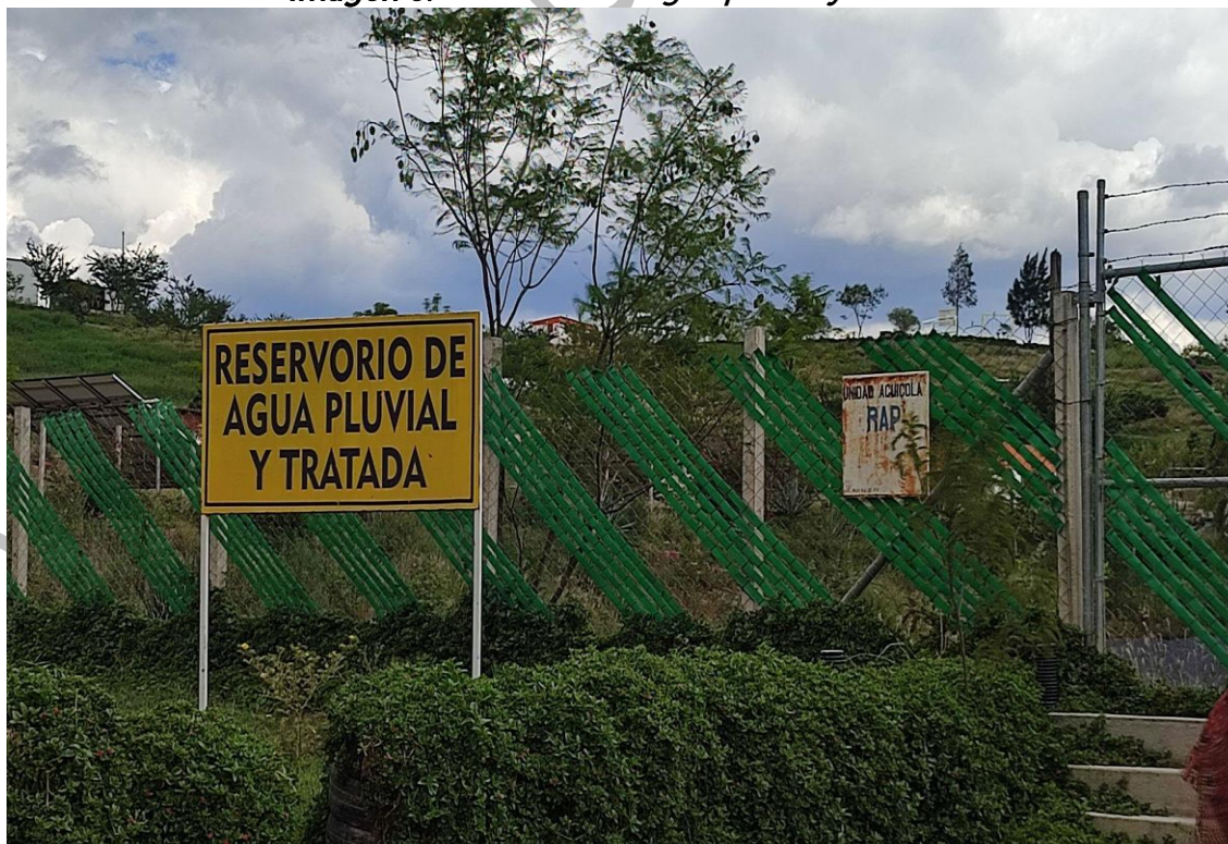
Imagen 6. Reservorio de agua pluvial y tratada
