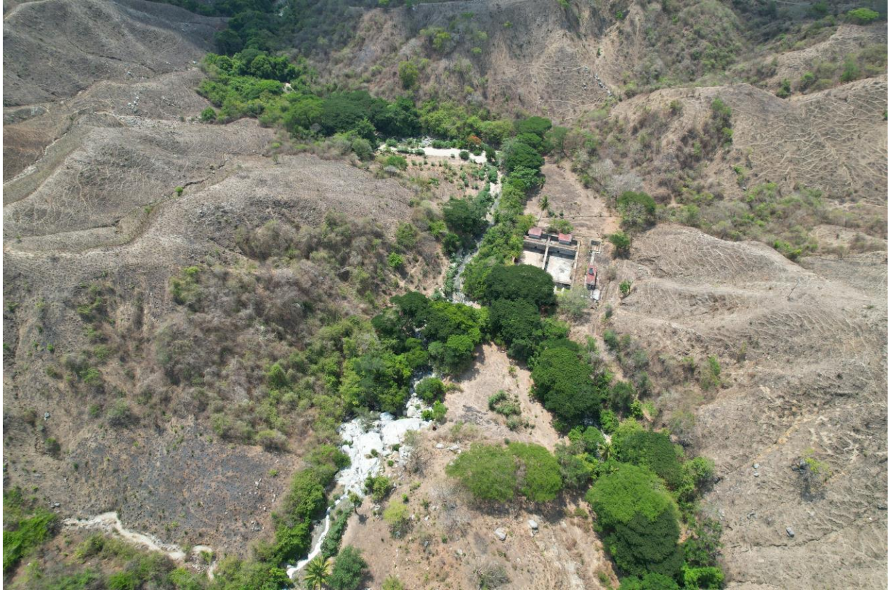
PTAR en desuso
