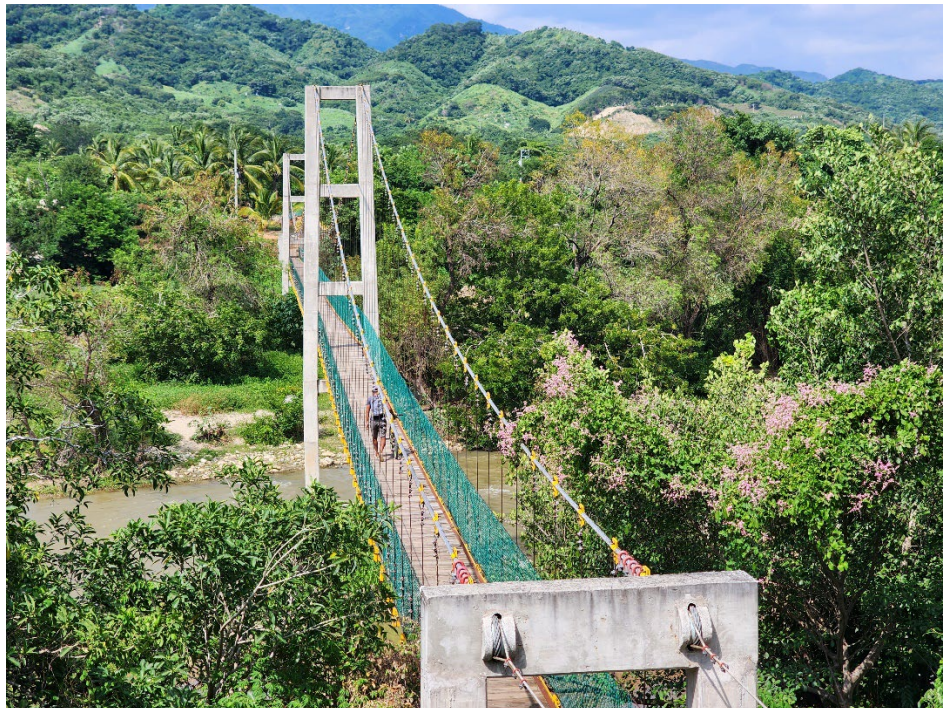
Ilustración 21. Puente en Santa María Colotepec
