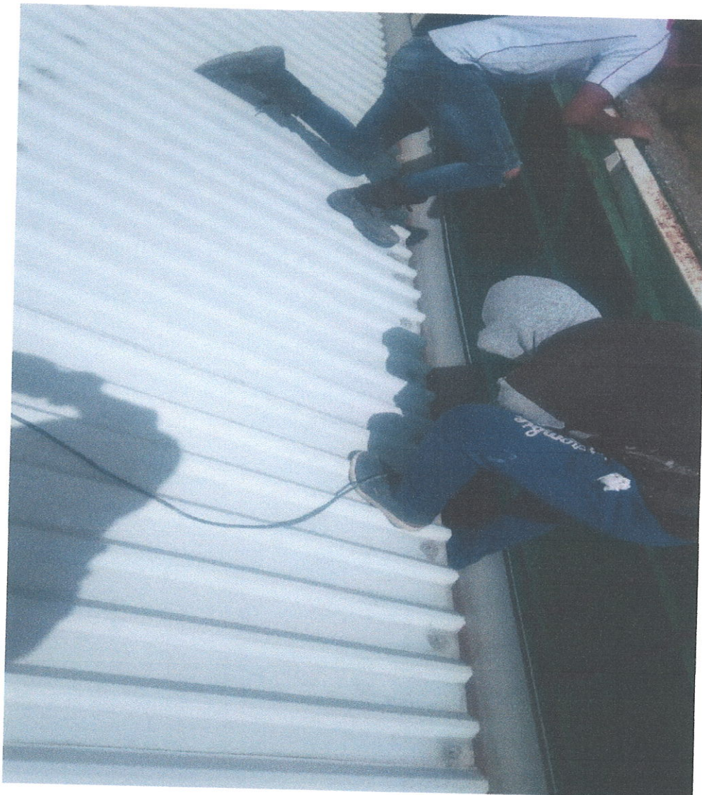
REPARACION DE CUBIERTA A BASE DE SELLADO.
