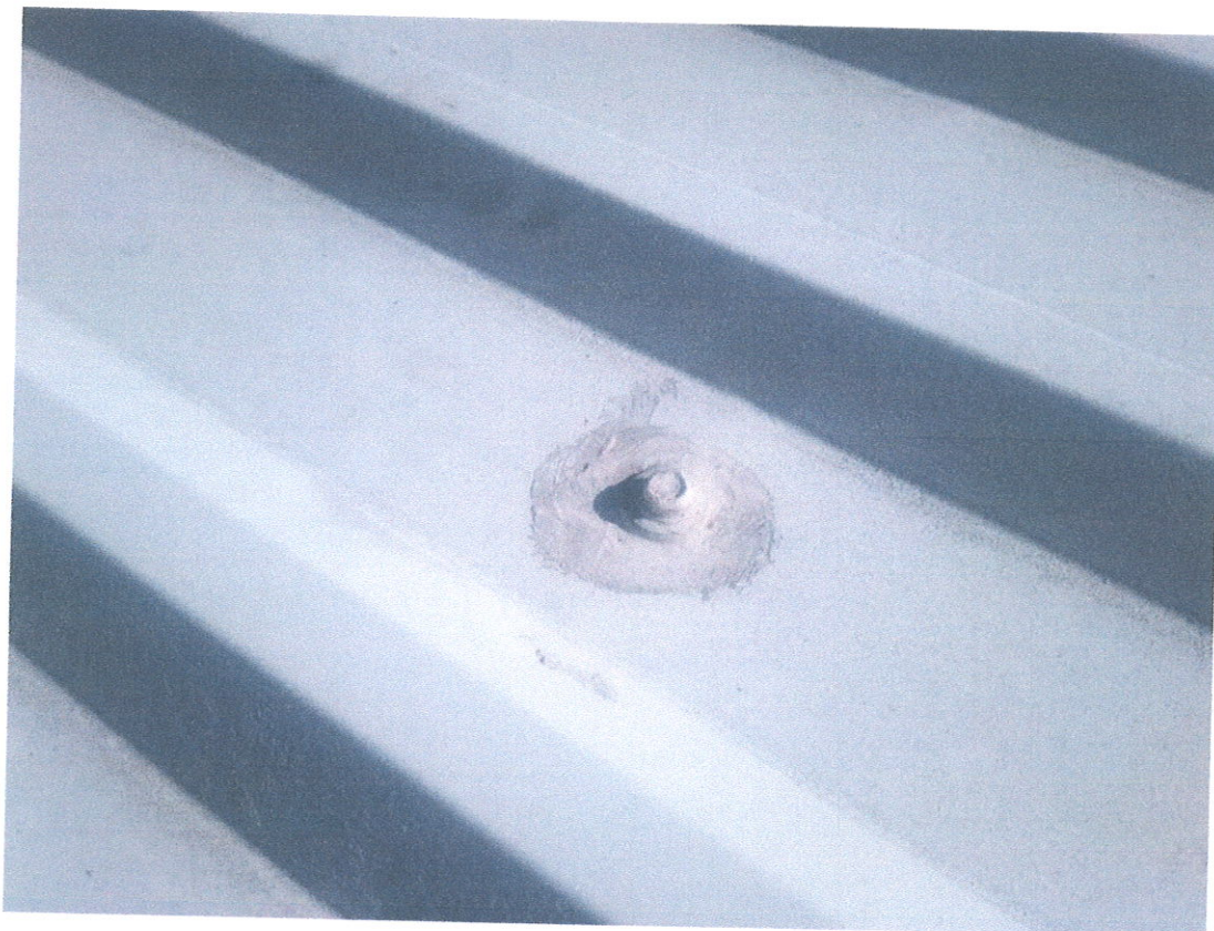
REPARACION DE CUBIERTA A BASE DE SELLADO.
