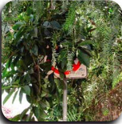
Obstrucción de señalamiento vial por la copa de un árbol.
