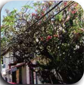
Conflictos de cableado y la copa de un árbol.
