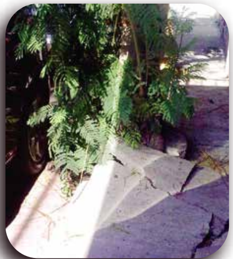
Levantamiento de banqueta.
