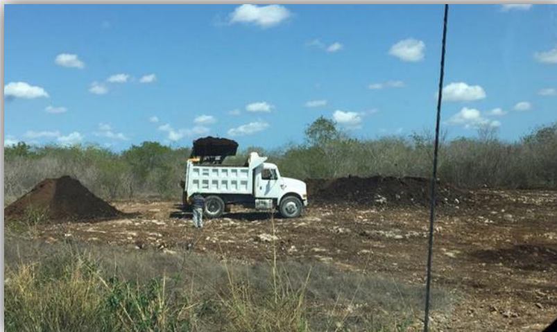
Fig. 3. Figura ilustrativa de un despalme.
