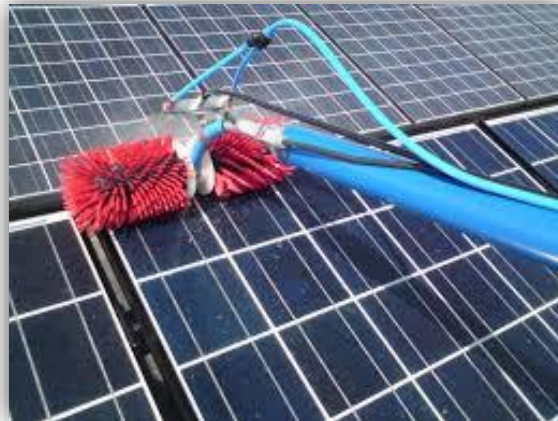
Fig. 9. Esquema de limpieza de los paneles fotovoltaicos.
