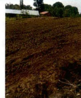
BORDO: SE OBSERVA LOS TRABAJOS PRELIMINARES DE LIMPIEZA Y DESENRAICE Y TRAZO Y NIVELACION PARA LA CONSTRUCCION DEL BORDO
