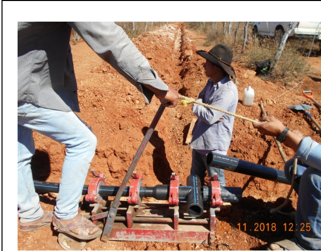
Colocación de piezas especiales (Stub End y Tee).
