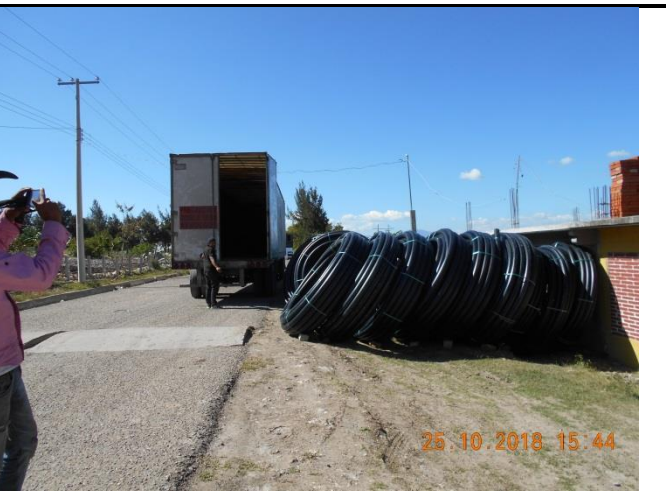
Suministro de tubería de 2" RD 11
