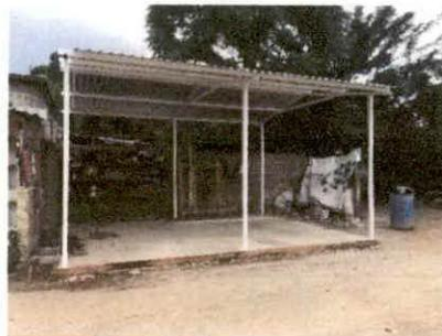
CON FECHA DE 6 DE NOVIEMBRE SE CONTINUAN LOS TRABAJOS DE FIRME DE 8 CM DE ESPESOR ACABADO COMÚN, DE CONCRETO F'C= 150 KG/CM2. EN LA COMUNIDAD DE SOLEDAD ETLA, OAXACA.
