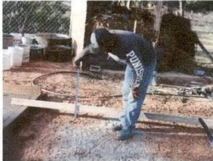
CON FECHA DE 22 DE OCTUBRE DEL 2018 SE INICIAN LOS TRABAJOS FIRME DE 8 CM DE ESPESOR ACABADO COMÚN, DE CONCRETO F'C= 150 KG/CM2.
