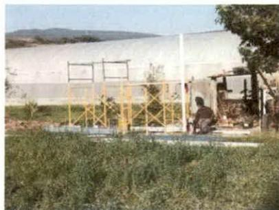
CON FECHA DE 6 DE NOVIEMBRE SE CONTINUAN LOS TRABAJOS DE FIRME DE 8 CM DE ESPESOR ACABADO COMÚN, DE CONCRETO F'C= 150 KG/CM2. EN LA COMUNIDAD DE SOLEDAD ETLA, OAXACA.
