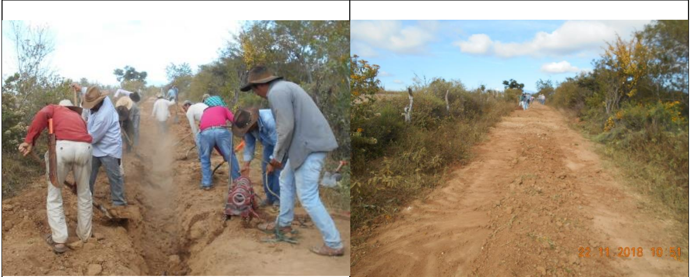
Tapado de zanja para tubería, acción final de la instalación de la línea de conducción en los tres ramales contemplados.
