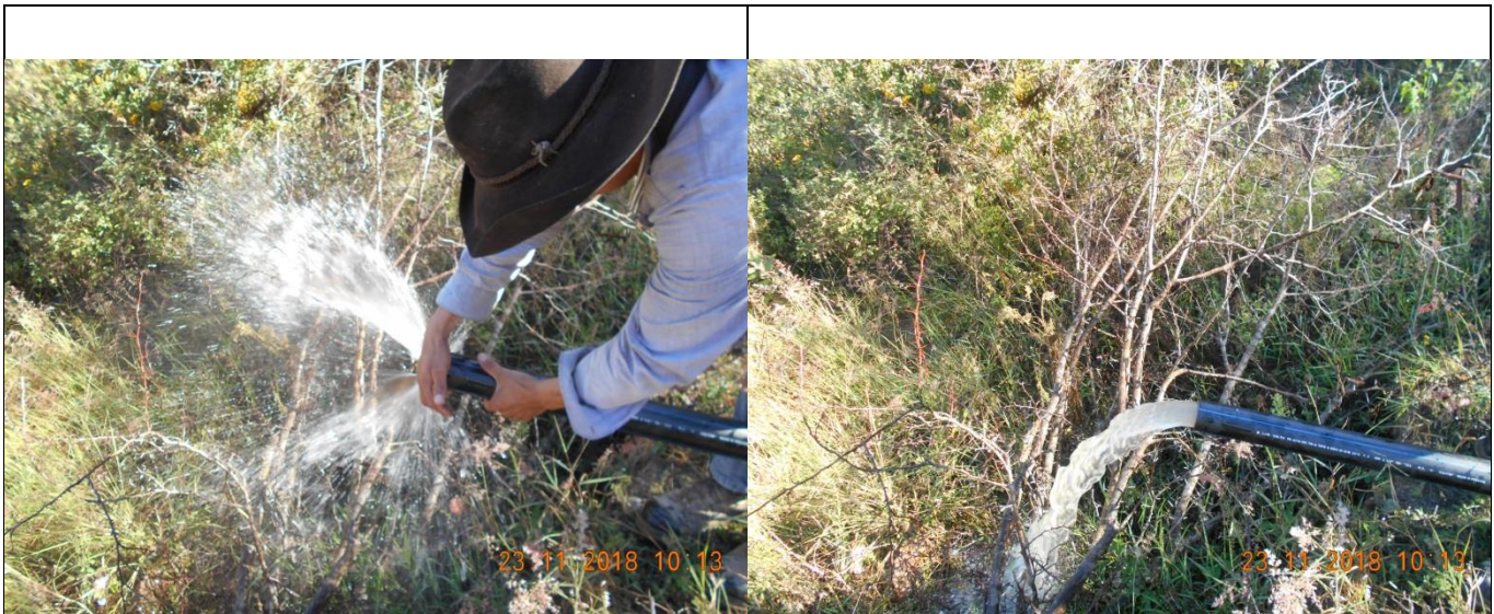
Prueba hidráulica de la línea de conducción en el ramal 1 "Portillo del gallo"
