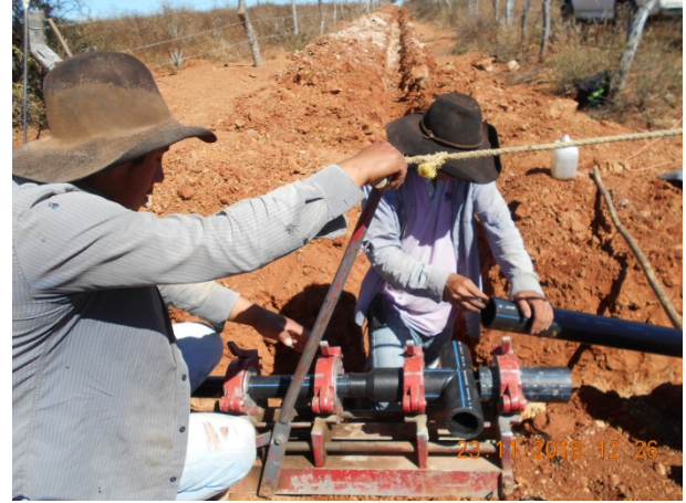
Colocación de piezas especiales (Stub End y Tee).
