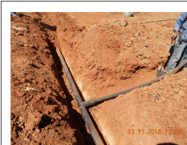
Colocación de piezas especiales
