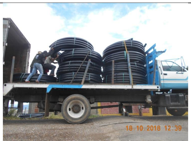
Suministro de tubería de 3" RD 17.
