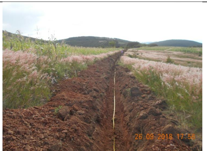
Excavación con retroexcavadora en material tipo B en el ramal 1
