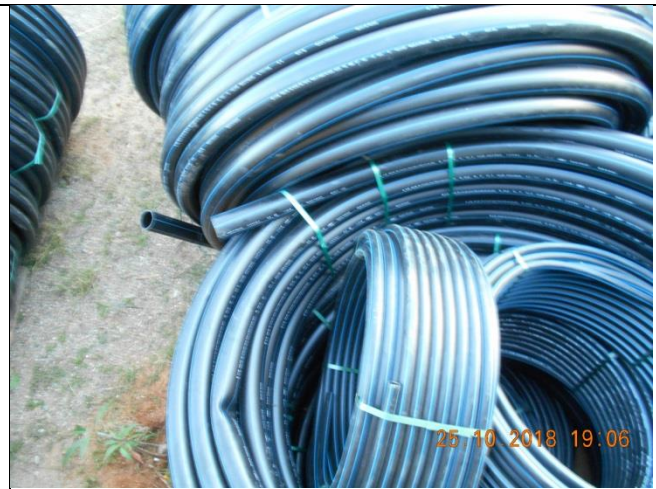
Suministro de tubería de 1" RD 13.5
