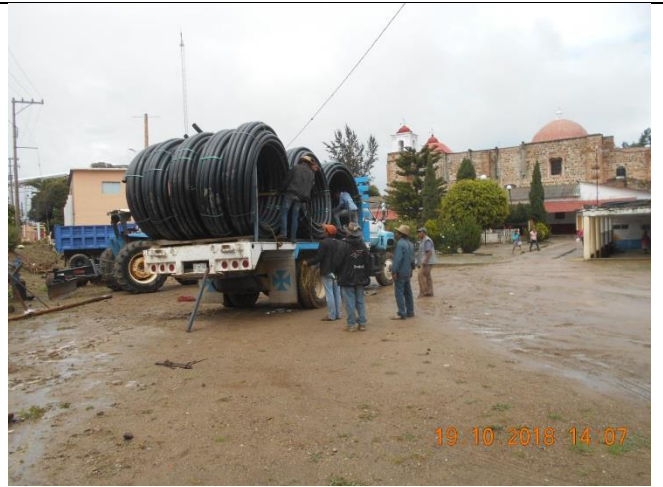
Acarreo de tubería de 3" RD 17 al sitio de obra.
