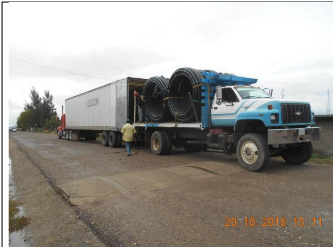
Suministro de tubería de 3" RD 15.5
