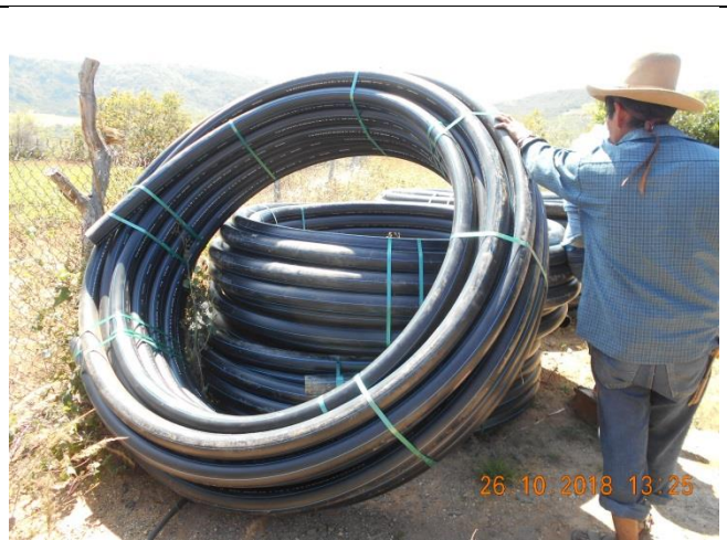
Suministro de tubería de 1", 2", 2 1/2" y 3" de acuerdo al proyecto, el material se encuentra en el sitio de obra.
