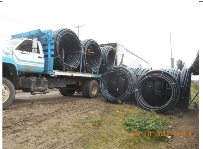
Suministro de tubería de 3" RD 15.5
