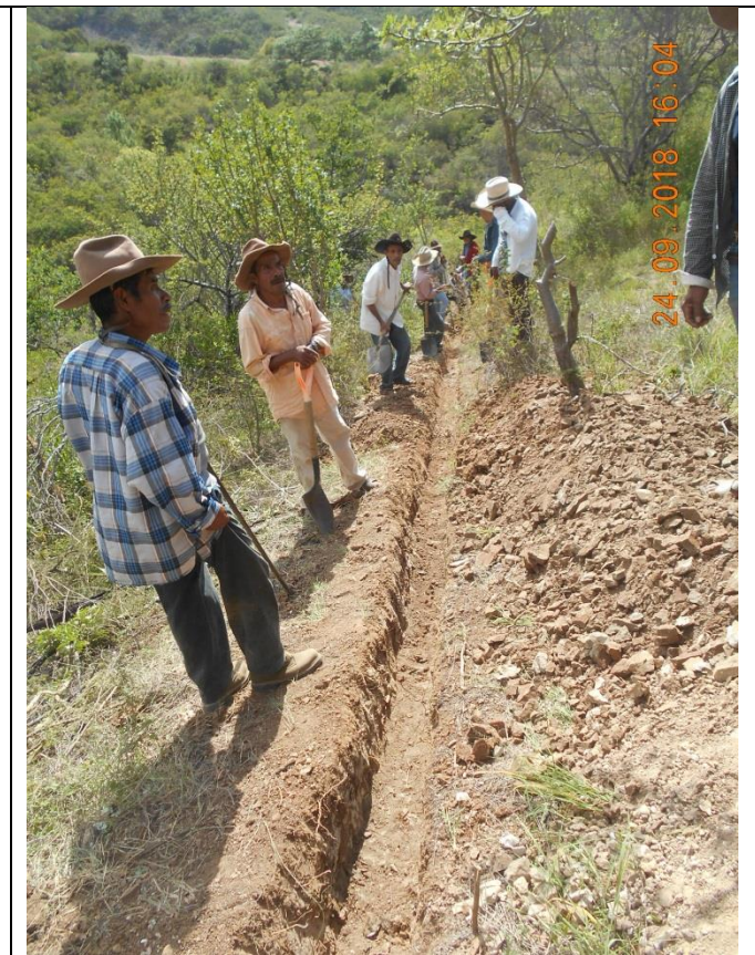
Excavación en forma manual en material tipo II en el ramal 1
