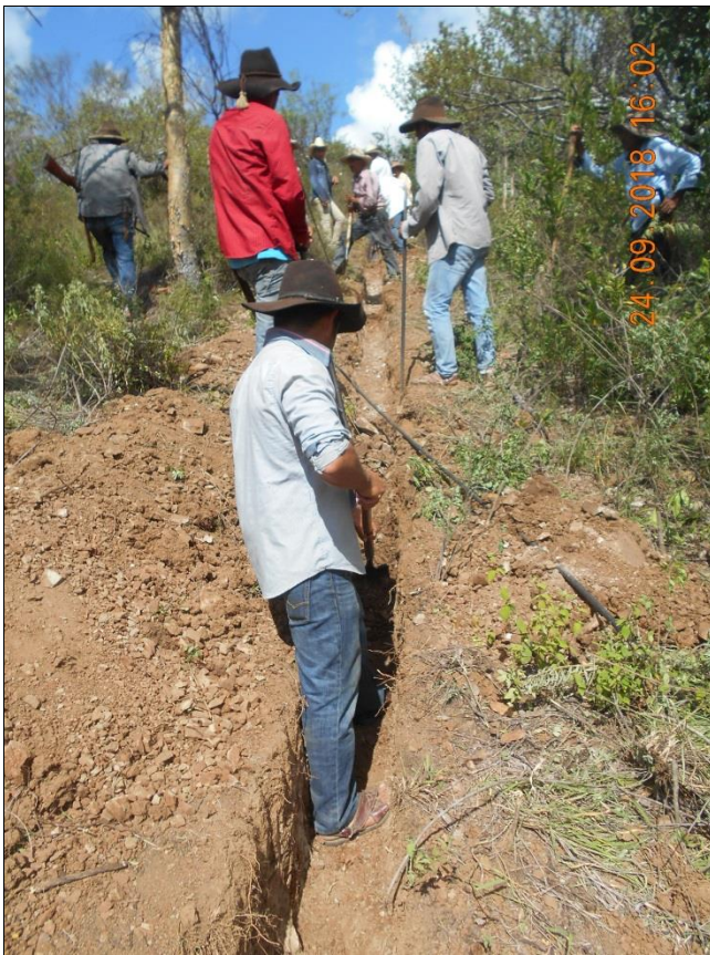
Excavación en forma manual en material tipo II en el ramal 1
