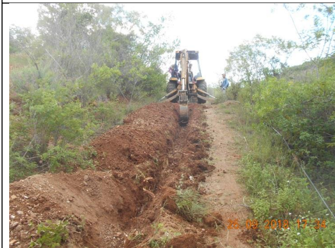
Excavación con retroexcavadora en material tipo B en el ramal 1
