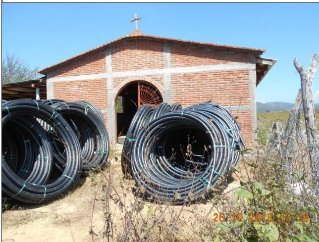
Suministro de tubería de 1", 2", 2 1/2" y 3" de acuerdo al proyecto, el material se encuentra en el sitio de obra.
