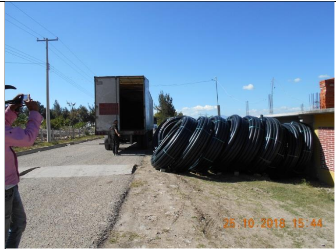
Suministro de tubería de 2" RD 11
