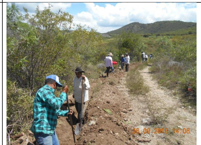
Excavación en forma manual
