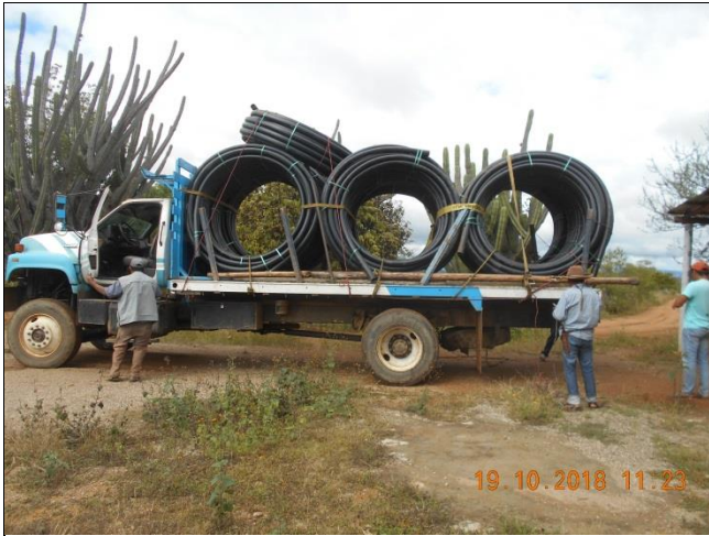
Acarreo de tubería de 3" RD 17 al sitio de obra.
