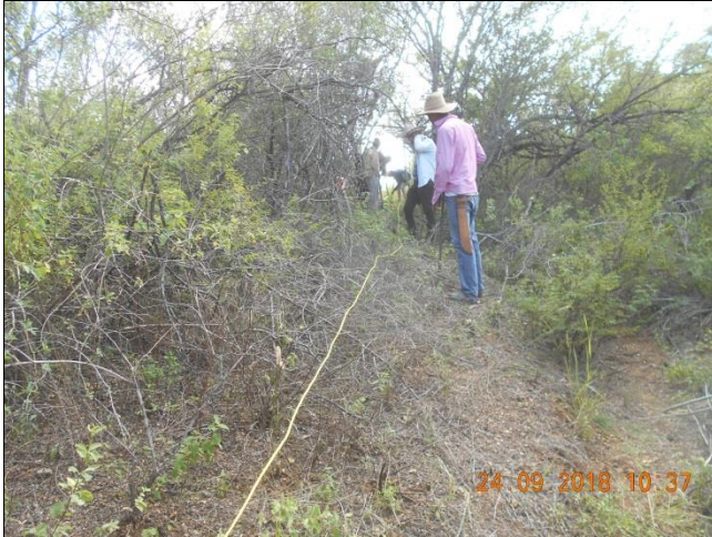
Limpiar y trazo de la línea de conducción en el ramal 1
