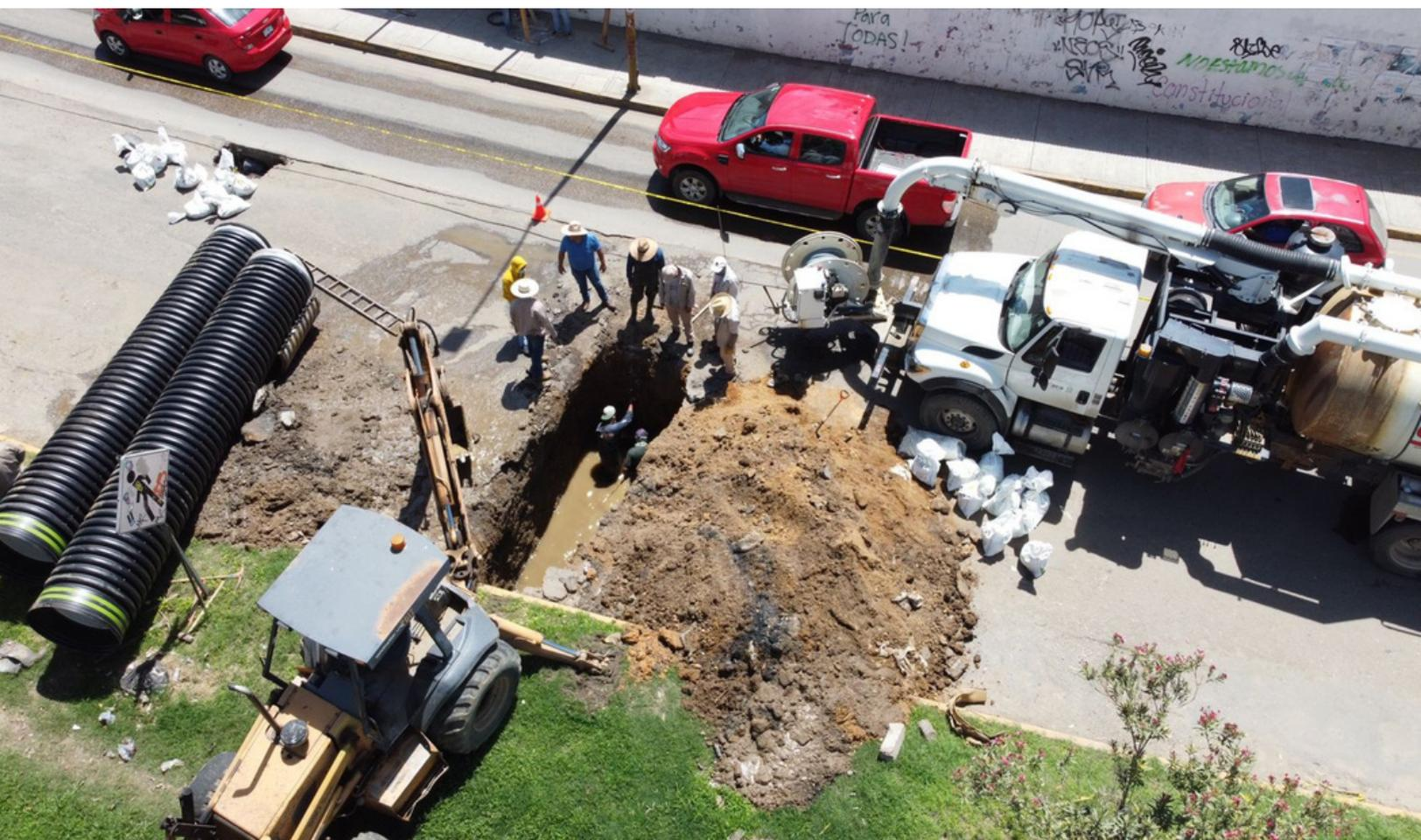
En lo posterior, el personal del área de alcantarillado, realizó las tareas de excavación del área a reparar, también se llevó a cabo el desazolve con el apoyo de equipo Vactor y posteriormente se efectuó la sustitución de tubería de drenaje, con la finalidad de restaurar a la brevedad los hundimientos originados.
