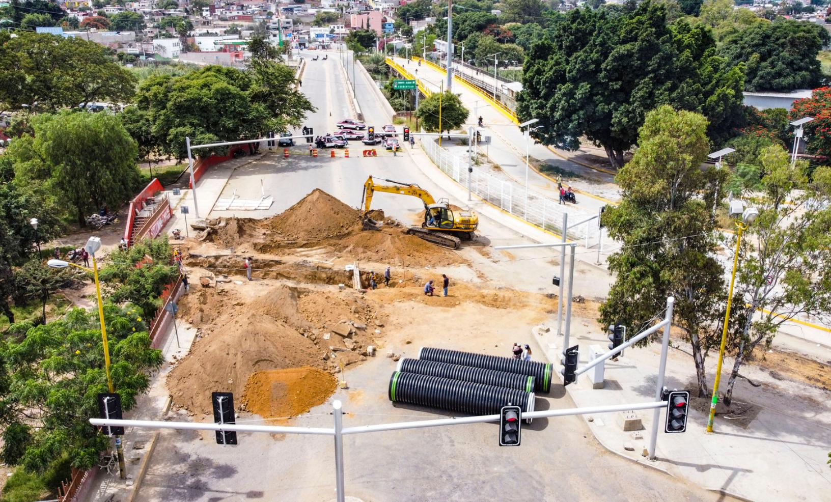
El proyecto comprende la instalación total de 185 metros líneales de tubería de PEAD de 48" de diámetro a 4 metros de profundidad y hasta el momento se lleva un avance del 60 por ciento de la obra. La renovación de esta infraestructura se debe al término de su periodo de utilidad, por lo cual era necesario ejecutar a la inmediatez su reemplazo para garantizar la conducción adecuada de las aguas residuales y a su vez evitar la manifestación de más hundimientos que originaran daños mayores.
