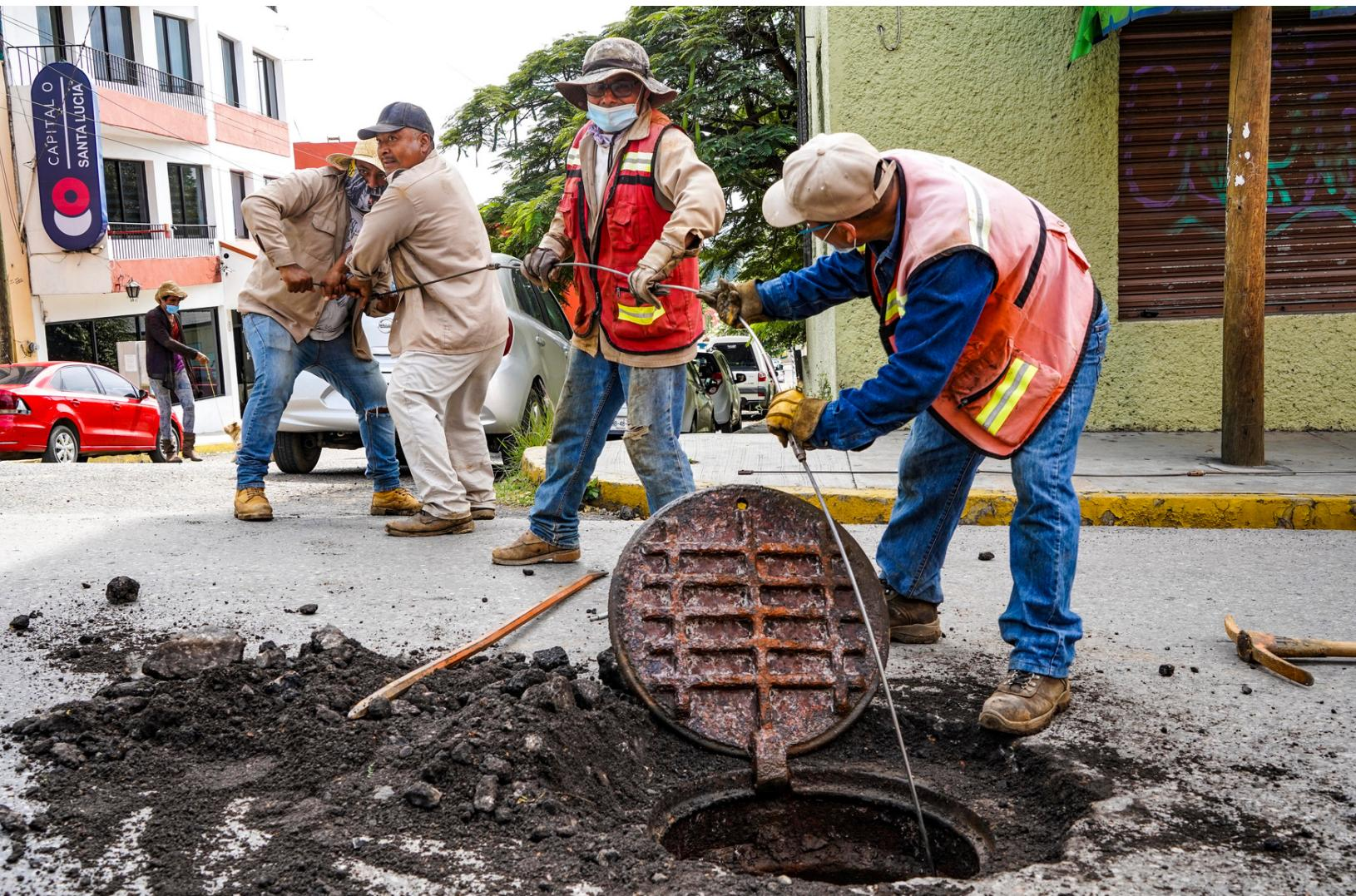
También, con el equipo tipo Vactor se realizó el desazolve y limpieza de la tubería de drenaje que obstruía algunas partes de la línea.
