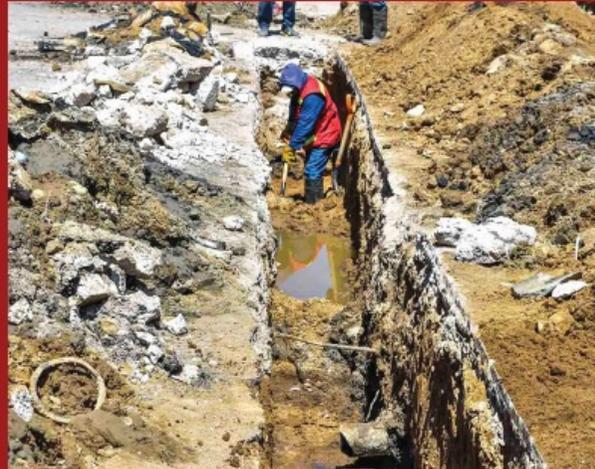
Debido al término de vida útil, la infraestructura de drenaje sanitario existente se ve amenazada por riesgo de colapso, debido al deterioro por el paso del tiempo, creando así la necesidad de rehabilitar tal estructura.
