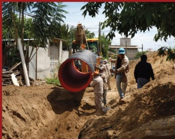
Con la ejecución de esta obra, se podrá lograr un incremento en la eficiencia hidráulica del sistema de alcantarillado sanitario ya que se optimizarán las pendientes en los tramos del proyecto a fin de evitar azolves en los pozos de visita, dejando en funcionamiento el colector de drenaje sanitario desde la calle Guillermo Prieto al puente de la Ex-Garita.
