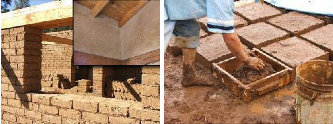
**Figura 4.4.** Construcción típica de muros de adobe.
