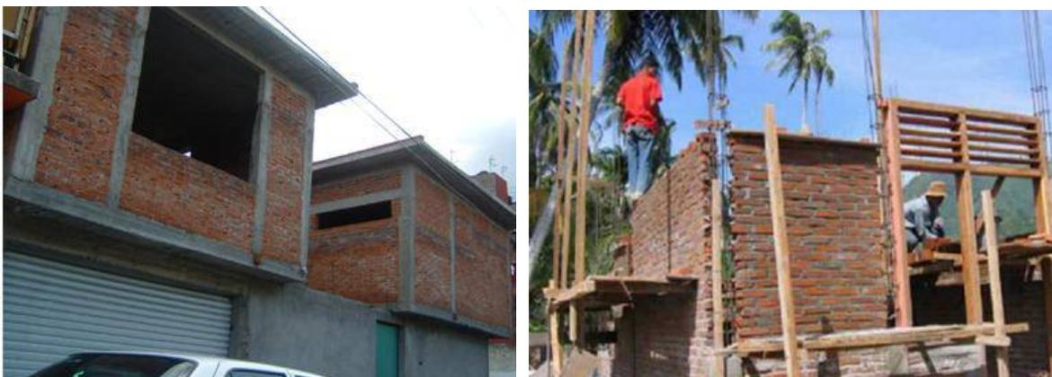
**Figura 4. 3.** Construcción típica de muros de mampostería.
