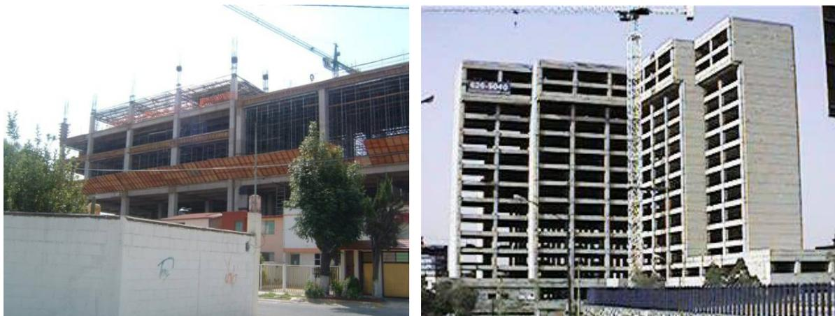
**Figura 4.9.** Construcción de marcos de concreto.
