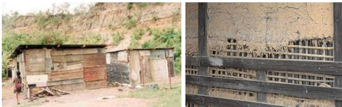
**Figura 4.7.** Construcción de materiales frágiles.
