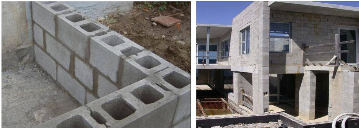
**Figura 4.5.** Construcción típica de muros de mampostería hueca.
