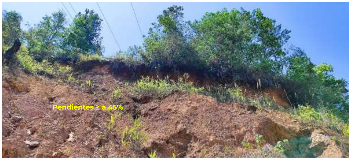
Imagen 14. Caída de detritos
