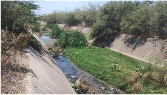
Imagen 9. Identificación del drenaje sin salida entre el Barrio Lachiguiri y la salida a Salina Cruz.
