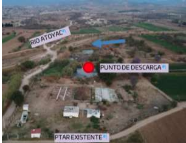
Imagen 5.5. Vista general de la PTAR Fuente: Elaboración propia).
