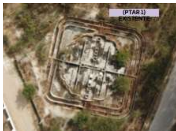
Imagen 5.9. Vista general de la PTAR (Fuente: Elaboración propia).
