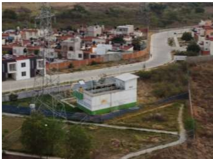
Imagen 5.18. Vista general de la PTAR (fuente: elaboración propia).
