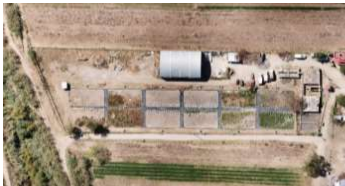
Imagen 5.40. Vista general de la PTAR (fuente: elaboración propia).
