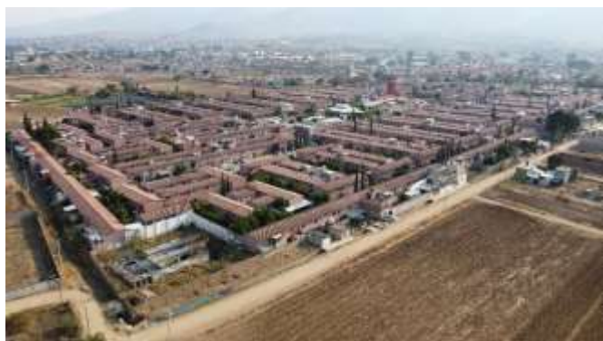
Imagen 5.22. Vista general de la PTAR (fuente: elaboración propia).
