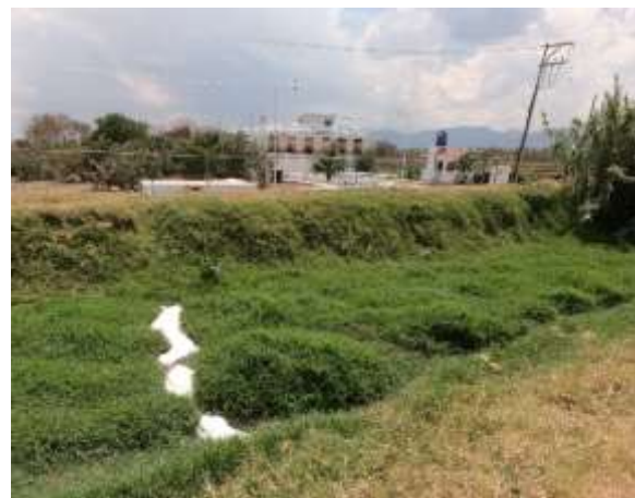
Imagen 6.3.16. Vista general de la descarga.
