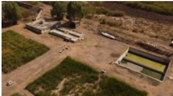
Imagen 5.34. Vista general de la PTAR (fuente: elaboración propia).
