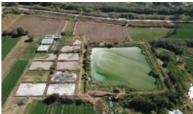
Imagen 5.12. Vista general de la PTAR (Fuente: elaboración propia).
