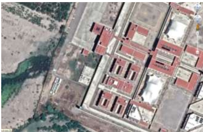
Imagen 5.26. Vista general de la PTAR (fuente: elaboración propia).
