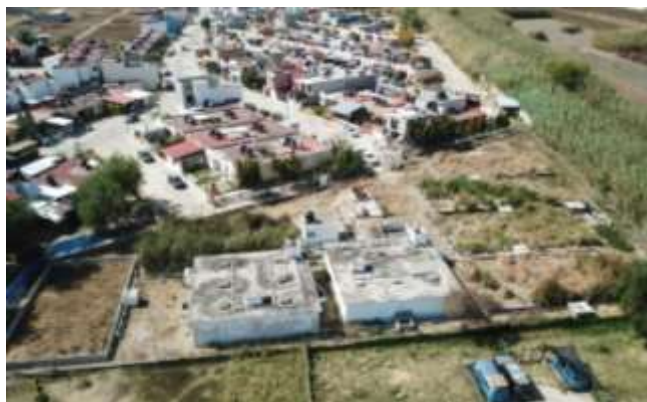
Imagen 5.16. Vista general de la PTAR (fuente: elaboración propia).
