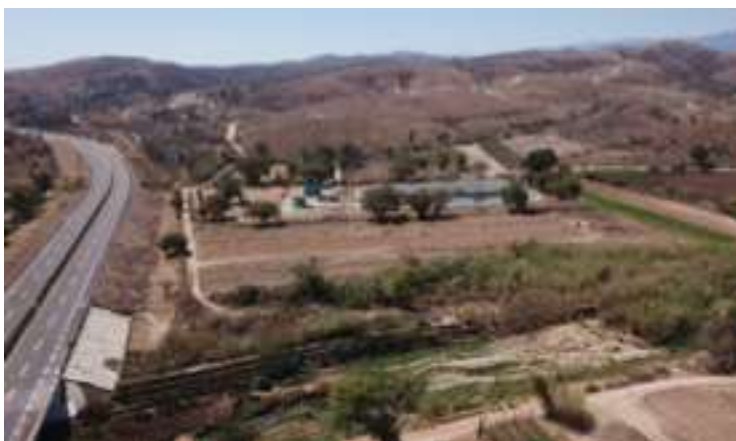
Imagen 5.7. Vista general de la PTAR (Fuente: Elaboración propia).
