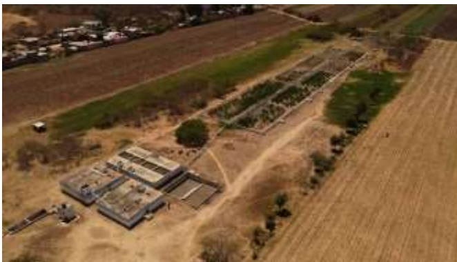
Imagen 6.3.5. Vista general de la PTAR (fuente: elaboración propia).
