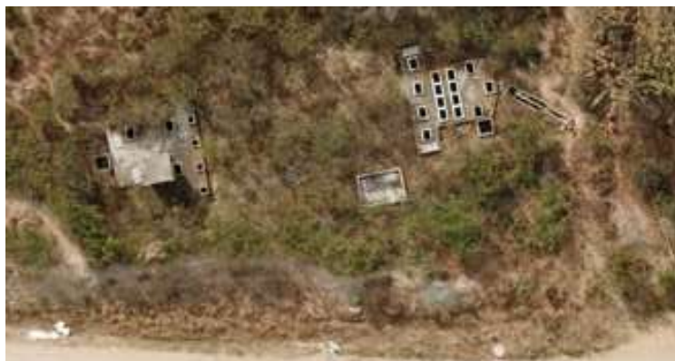
Imagen 5.10. Vista general de la PTAR (Fuente: Elaboración propia).
