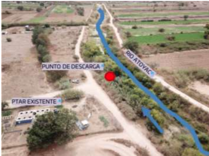
Imagen 5.3. Vista general de la PTAR (Fuente: Elaboración propia).
