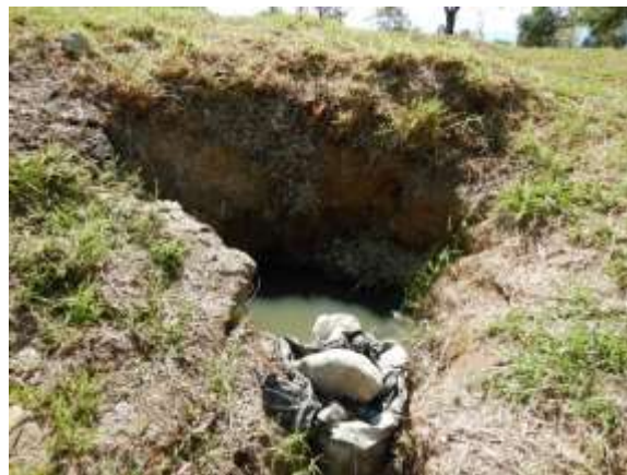
Imagen 5.15. Vista general de la PTAR (Fuente: elaboración propia)
