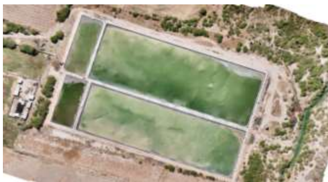
Imagen 5.28. Vista general de la PTAR (fuente: elaboración propia).
