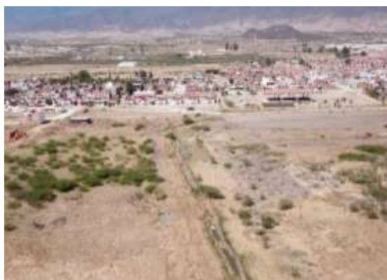
Imagen 5.30. Vista general de la PTAR (fuente: elaboración propia).
