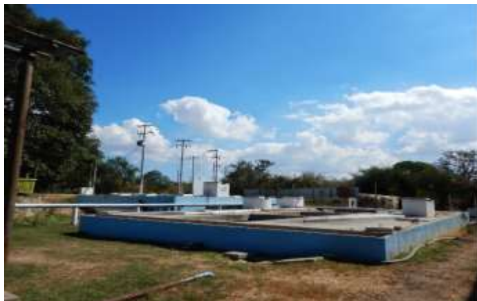
Imagen 5.14. Vista general de la PTAR (Fuente: elaboración propia)
