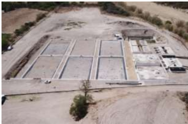
Imagen 5.24. Vista general de la PTAR (fuente: elaboración propia).
