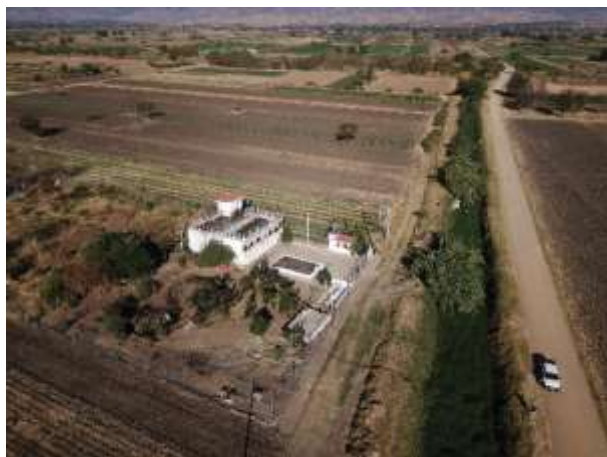
Imagen 6.3.15. Vista general de la PTAR.
