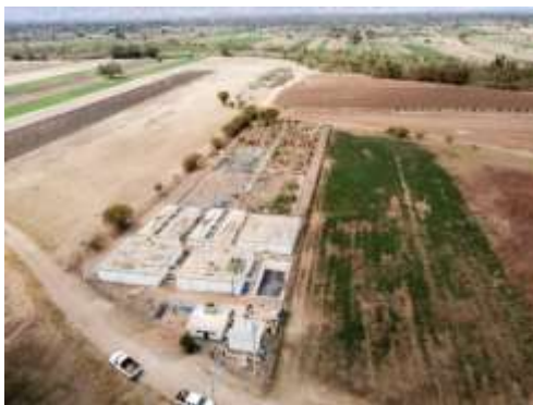
Imagen 6.3.7. Vista general de la PTAR (fuente: elaboración propia).
