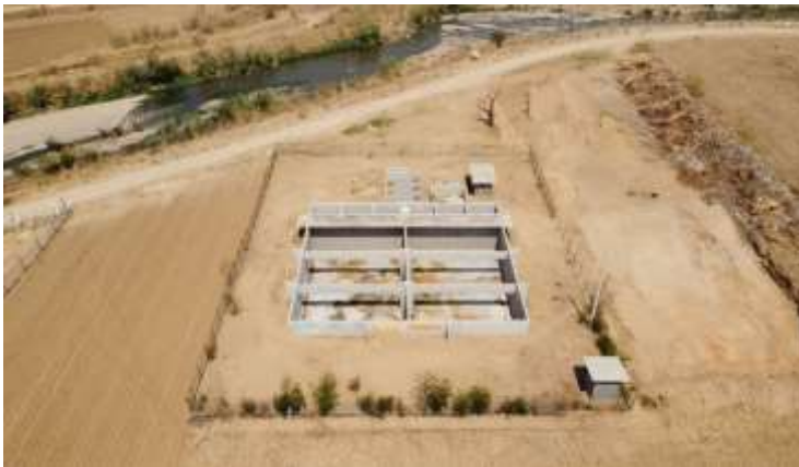
Imagen 6.3.1. Vista general de la PTAR (fuente: elaboración propia).
