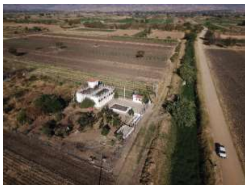
Imagen 6.3.9. Vista general de la PTAR (fuente: elaboración propia).
