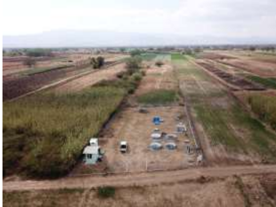
Imagen 6.3.13. Vista general de la PTAR (fuente: elaboración propia).
