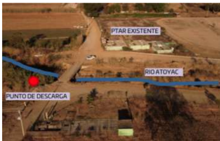
Imagen 5.1. Vista general de la PTAR (Fuente: Elaboración propia).
