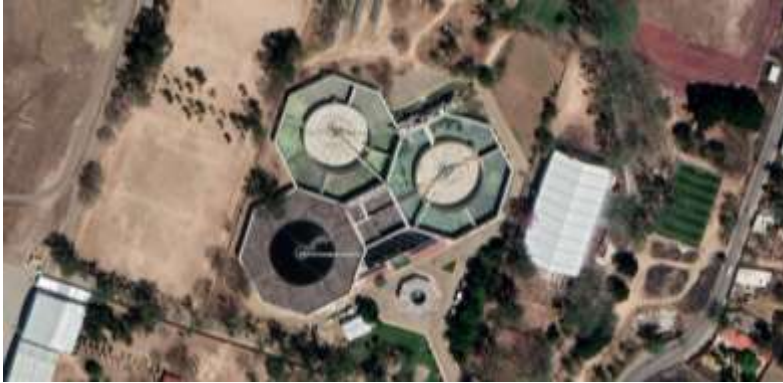
Imagen 6.3.3. Vista general de la PTAR (fuente: elaboración propia).
