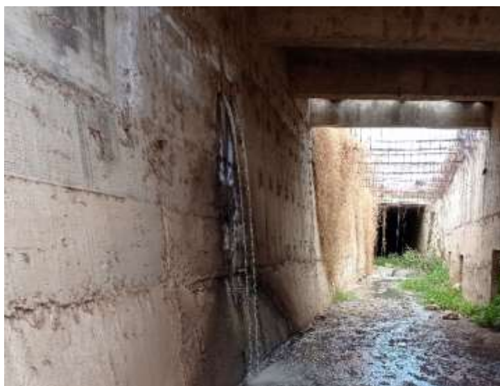
Imagen 5.20. Vista general de la PTAR (fuente: elaboración propia).
