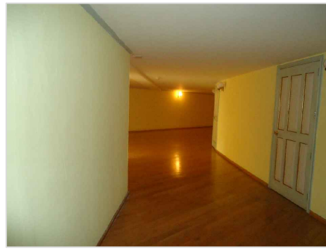
IMAGEN 01: SE MUESTRA EL PISO CON ENDEULADO DE MADERA DE ENCINO BARNIZADO Y MURO DE 18CM DE ESPESOR DE LADRILLO CON ACABADO INTERMEDIO DE APLANADO Y ACABADO FINAL DE PINTURA VINÍLICA COLOR BEIGE
