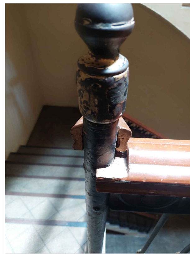
IMAGEN 02: PIEZA DECORATIVA DE BARANDAL DE CUBO DE ESCALERAS CON DESPRENDIMIENTO DE PINTURA, A CAUSA DE USO CONSTANTE Y FALTA DE MANTENIMIENTO.
