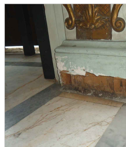
IMAGEN 04: MARCO POLICROMADO DE MADERA EN MAL ESTADO CON DESPRENDIMIENTOS DE MADERA Y DEBILITAMIENTO POR ATAQUE XILOFAGO.
