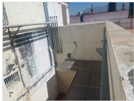
IMAGEN 15: MUROS DE LADRILLO CON APLANADO CEMENTO-CAL-ARENA CON ACABADO FINAL CON PINTURA VINÍLICA COLOR CREMA.
