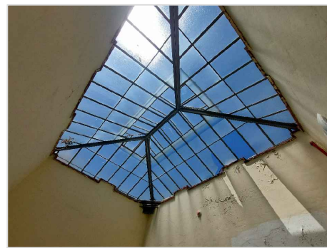
IMAGEN 17: DOMO CON ESTRUCTURA DE CABALLETE DE 2.80X2.10 CON PIEZAS DE VIDRIO ESMERILADO.
