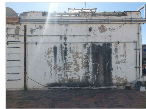
IMAGEN 25: PRESENCIA DE MOHO EN MURO A CAUSA DE ESCURRIMIENTO DE AGUA PLUVIAL.
