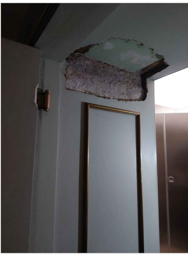
IMAGEN 03: CONTRAMARCO DE PUERTA A BASE DE TRIPLAY DE MADERA DE PINO DE 6MM LAQUEADO DAÑADO CON DESPRENDIMIENTO A CAUSA DE HUMEDAD.
