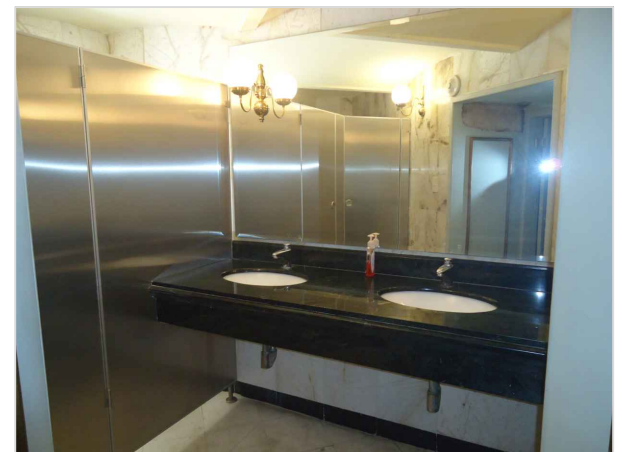
IMAGEN 01: LAVABO DE GRANITO NEGRO, CON PLACAS DE 5CM DE ESPESOR, ACABADO PULIDO.
