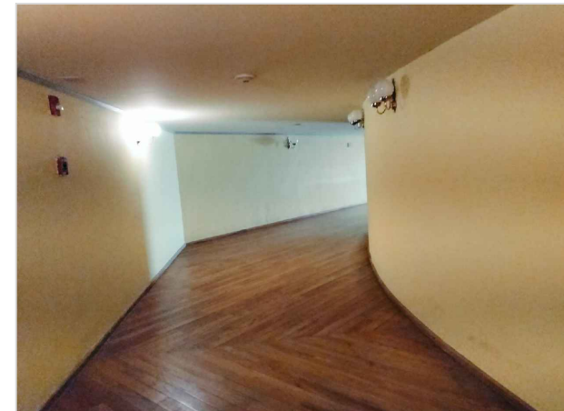
IMAGEN 06: PISO ENDUELAO DE MADERA MACHIMBRADA DE ENCINO CON DUELAS DE 12CMX2.40MX2CM DE ESPESOR Y ACABADO FINAL CON BARNIZ TRANSPARENTE.
