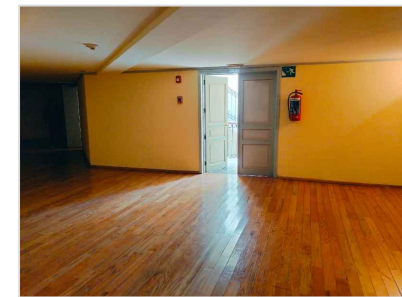
IMAGEN 02: SE MUESTRA EL PISO CON ENDUELO DE MADERA DE ENCINO BARNIZADO Y MURO DE 18CM DE ESPESOR DE LADRILLO CON ACABADO INTERMEDIO DE APLANADO Y ACABADO FINAL DE PINTURA VINILICA COLOR BEIGE
