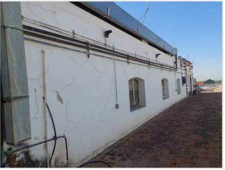
IMAGEN 10: MUROS DE LADRILLO CON APLANADO CEMENTO-CAL-ARENA CON ACABADO FINAL CON PINTURA VINÍLICA COLOR CREMA.
