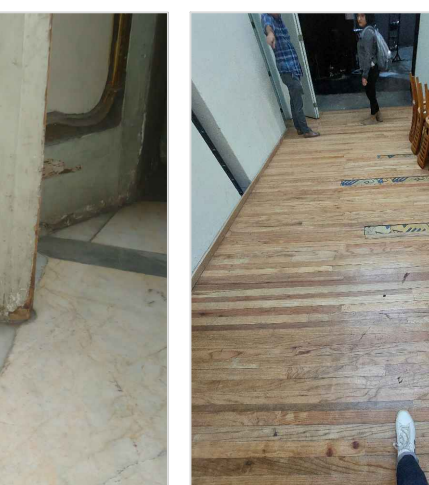
IMAGEN 05: DESPRENDIMIENTO DE PZAS DE MADERA A CAUSA DE FALTA DE MANTENIMIENTO.
