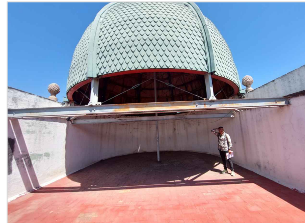
IMAGEN 07: CÚPULA A BASE DE ESTRUCTURA DE HERRERIA Y FORRADA DE MADERA MACHIMBRADA ENTABLERADO EN CÚPULA DE 10 CM X 3 CM CADA UNA.
