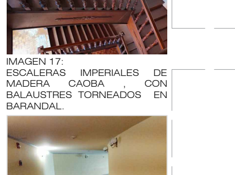
IMAGEN 17: ESCALERAS IMPERIALES DE MADERA, CACERA CON BALAUSTRAS TORNEADOS EN BARANDAL.
