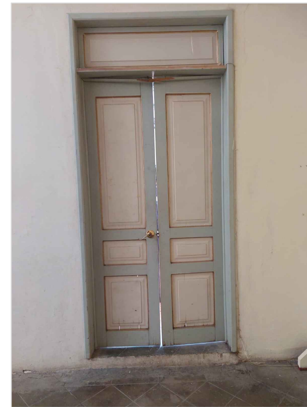
IMAGEN 06: PUERTA DE MADERA 2.40X1.48M DE MADERA DE PINO CON CONTRAMARCO, LAQUEADA CON PINTURA COLOR VERDE PISTACHE Y BLANCO, EN MAL ESTADO POR INTEMPERISMO Y FALTA DE MANTENIMIENTO.
