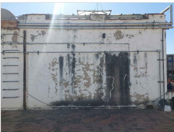
IMAGEN 04: PRESENCIA DE MOHO EN MURO A CAUSA DE ESCURRIMIENTO DE AGUA PLUVIAL.
