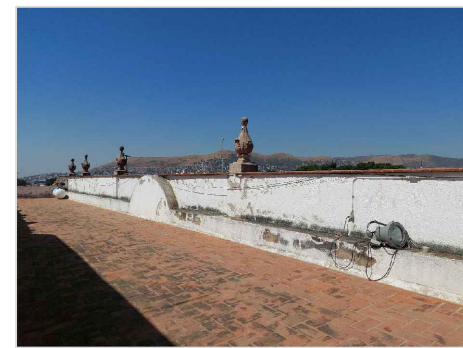
IMAGEN 23: PRESENCIA DE MOHO EN ENLADRILLADO Y MURO PRETEL A CAUSA DE INTEMPERISMO Y FALTA DE MANTENIMIENTO.
