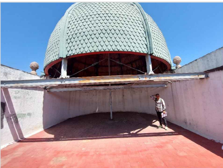
IMAGEN 09: CÚPULA A BASE DE ESTRUCTURA DE HERRERIA Y FORRADA DE MADERA MACHIMBRADA ENTABLERADO EN CÚPULA DE 10 CM X 3 CM CADA UNA.
