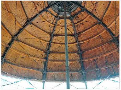
IMAGEN 14: CÚPULA A BASE DE ESTRUCTURA DE HERRERIA Y FORRADA DE MADERA MACHIMBRADA ENTABLERADO EN CÚPULA DE 10 CM X 3 CM CADA UNA.
