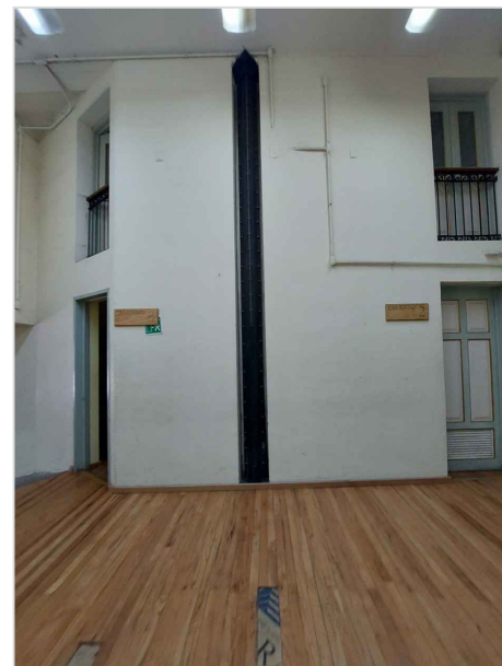
IMAGEN 09: MUROS DE LADRILLO CON ACABADO APLANADO Y ACABADO FINAL DE PINTURA VINÍLICA EN COLOR BLANCO, ADemás DE COLUMNA DE ACERO REMACHADO, CON UN ACABADO DE PINTURA ANTICORROSIVA NEGRA, ENCAJONADO ENTRE MUROS DE MAMPOSTERÍA.
