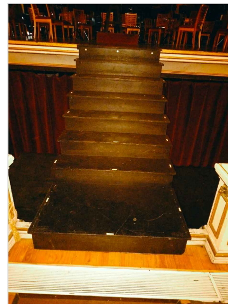
IMAGEN 06: ESCALERAS DE MADERA TRIPLAY DE 9MM, PINTADAS DE COLOR NEGRO PARA ACCESAR A ESCENARIO SOBRE FOSA DE ORQUESTA.
