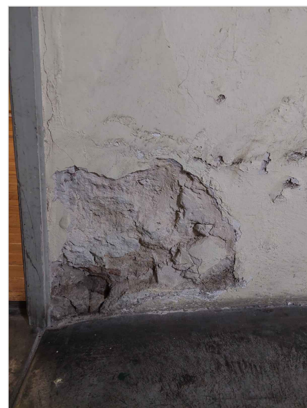
IMAGEN 07: DISGREGACIÓN APLANADO EN MURO A UN COSTADO DE PUERTA DE CAMERINO A CAUSA DE SISMOS, GOLPES Y FALTA DE MANTENIMIENTO.
