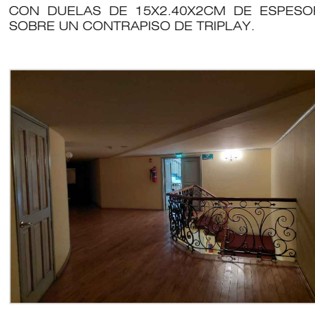
IMAGEN 15: PISO DE MADERA MACHIMBRADA DE ENCIÑO CON DUELAS DE 15X2.40X2CM DE ESPESOR SOBRE UN CONTRAPISO DE TRIPLAY.
