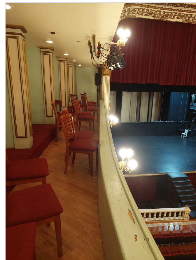
IMAGEN 01: PRETIL DE MADERA DE 25CM DE ANCHO CON DESPRENDIMIENTOS Y DETERIORO ESTRUCTURAL POR ATAQUE XILOFAGO.
