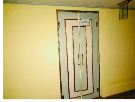
IMAGEN 05: PUERTA DE MADERA CON ACABADO LAQUEADO EN COLOR VERDE PISTACHE Y BLANCO, CON DETALLES Y MOLDURAS DE MADERA EN COLOR DORADO.
