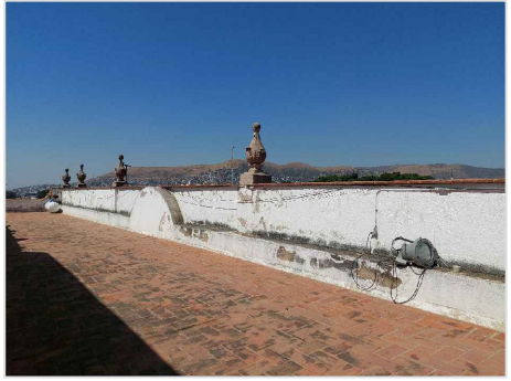
IMAGEN 11: ENLADRILLADO A BASE DE TABIQUE ROJO RECOCIDO TIPO MEDIA TABLA COLOCADOS EN DISPOSICIÓN DE RETÍCULO, ASIENTADO CON MORTERO DE CAL-ARENA PROP. 1:3 + 10% DE CEMENTO GRIS POR VOL. DE CAL.
