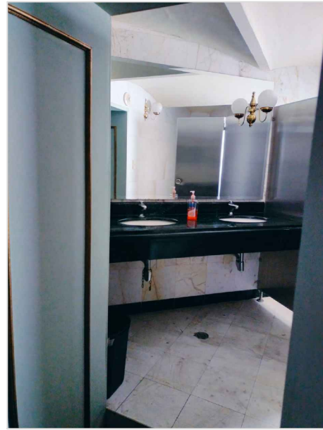
IMAGEN 04: INTERIOR DE BAÑO CON PISO DE MÁRMOL COLOR BLANCO CON VETAS GRISAS CON LAVADO DE GRANITO NEGRO ACABADO PULIDO.
