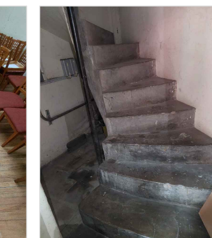
IMAGEN 06: DISGREGACIÓN DE APLANADO POR HUMEDAD A CAUSA DE CAPILARIDAD.
