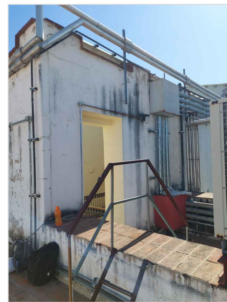
IMAGEN 22: ENLADRILLADO EN MURETE, Y PRESENCIA DE MOHO EN MISO A CAUSA DE ESCURRIMIENTO DE AGUA PLUVIAL.
