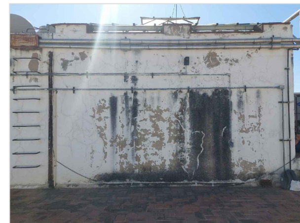
IMAGEN 11: PRESENCIA DE MOHO EN MURO A CAUSA DE ESCURRIMIENTO DE AGUA PLUVIAL.
