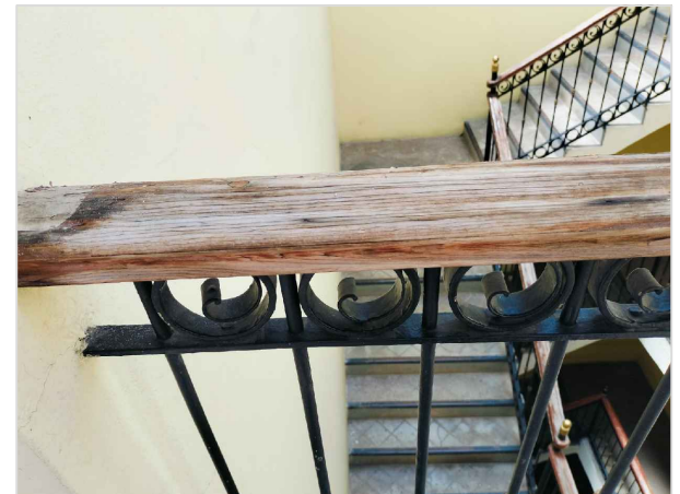
IMAGEN 02: PASAMANOS DE 8X6CM DE MADERA DE ENCINO CON ACABADO ENTINTADO FIJADO A BARANDAL DE 90CM DE ALTURA.
