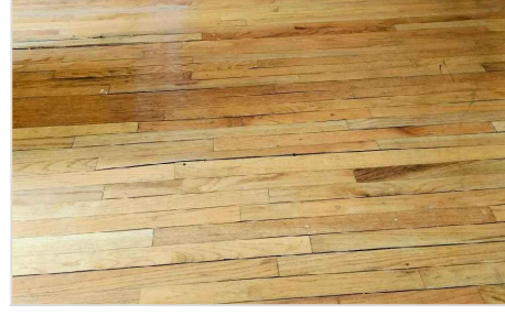
IMAGEN 07: SE MUESTRA EL PISO CON ENDEULADO DE MADERA DE ENCINO BARNIZADO Y MURO DE 18CM DE ESPESOR DE LADRILLO CON ACABADO INTERMEDIO DE APLANADO Y ACABADO FINAL DE PINTURA VINÍLICA COLOR BEIGE
