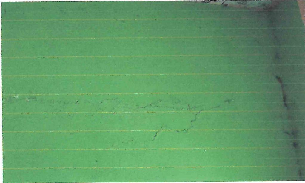
Imagen 10. Grietas en el aplanado causando desprendimientos. Fuente: Visita técnica, septiembre 2021
