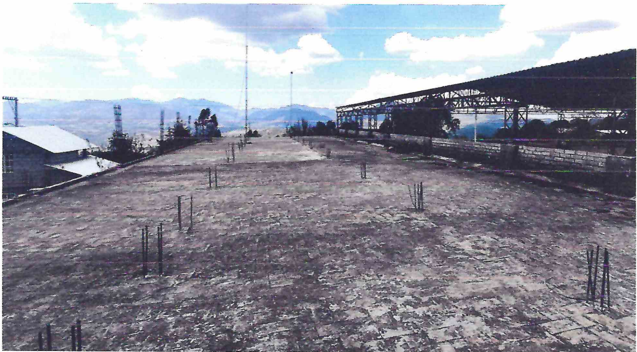
Imagen 15. Daños en losa de azotea, se observa deterioro en el petatillo. Fuente: Visita técnica, septiembre 2021
