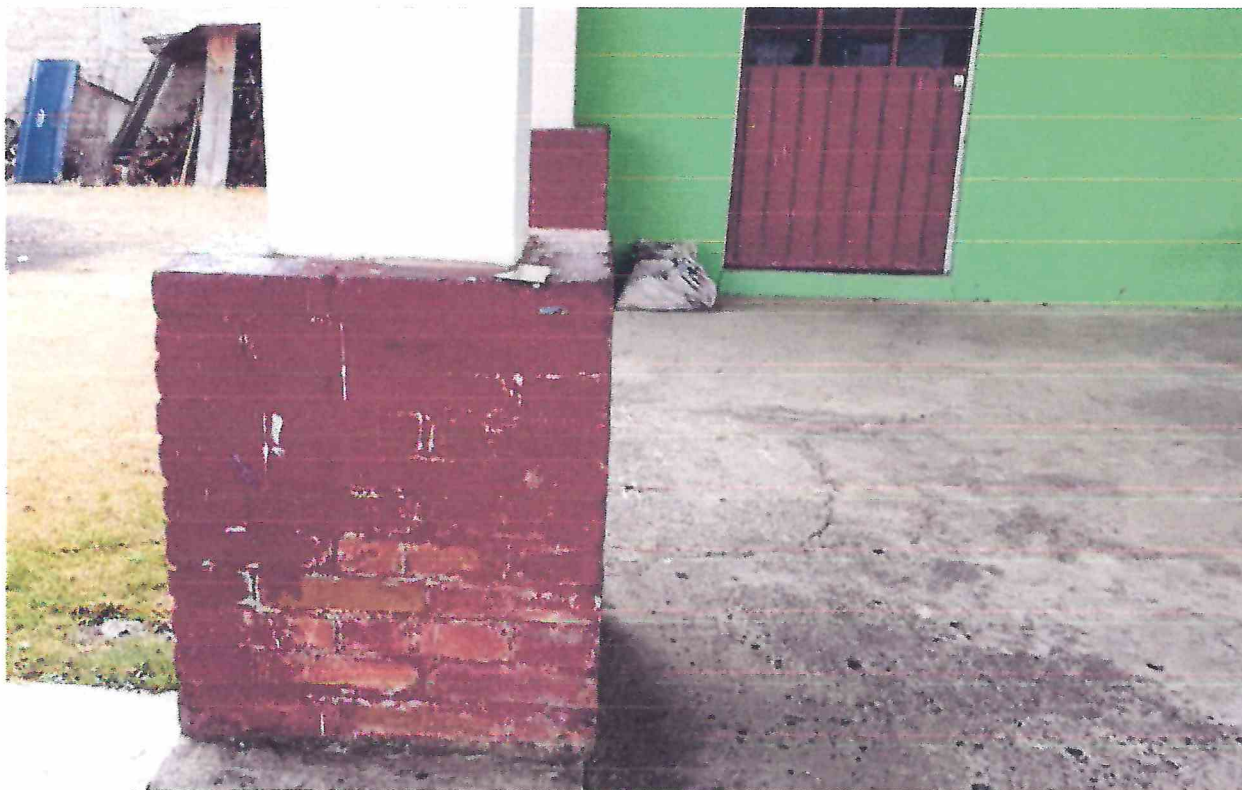
Imagen 14. Piezas de tabique de barro rojo recocido y acabado final de pintura vinílica en mal estado. Fuente: Visita técnica, septiembre 2021
