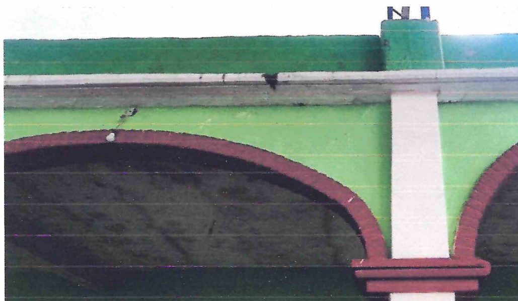
Imagen 12. Daños, agrietamientos y desprendimiento de aplados en muro exterior. Fuente: Visita técnica, septiembre 2021
