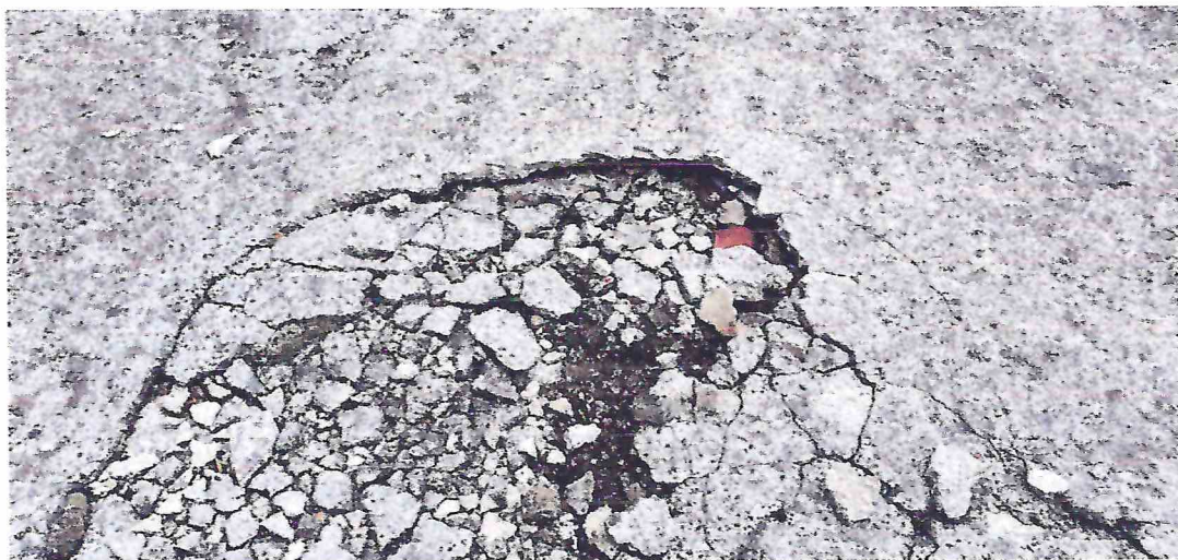
Imagen 17. Desprendimiento y agrietamiento de entortadosa consecuencia de los sismos. Se observa humedad en el elemento. Fuente: Visita técnica, septiembre 2021
