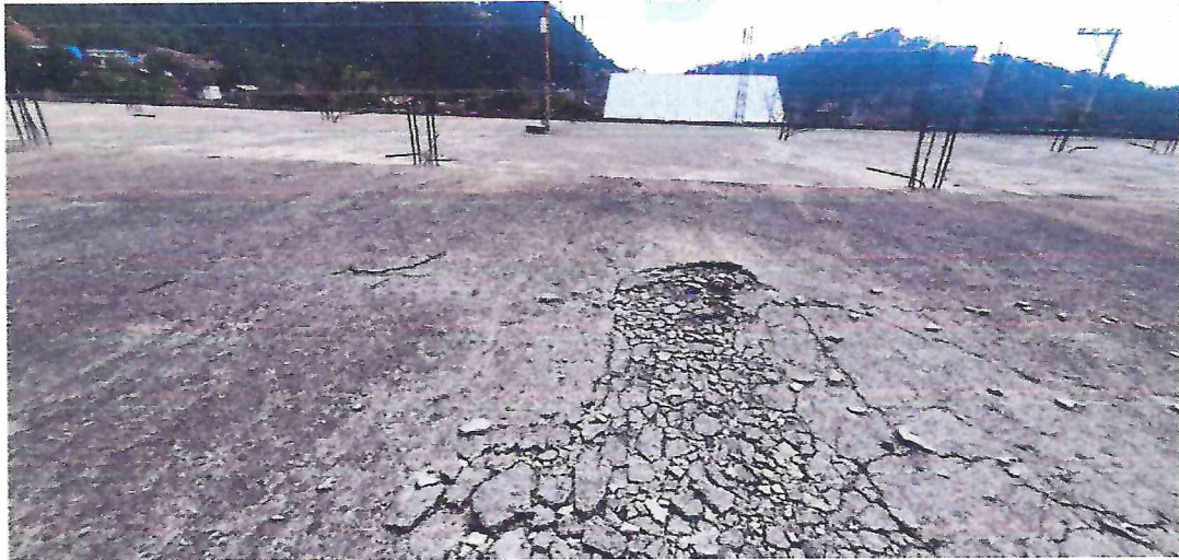
Imagen 16. Desprendimiento del entortado de cubierta por presencia de grietas a causa de sismo. Fuente: Visita técnica, septiembre 2021
