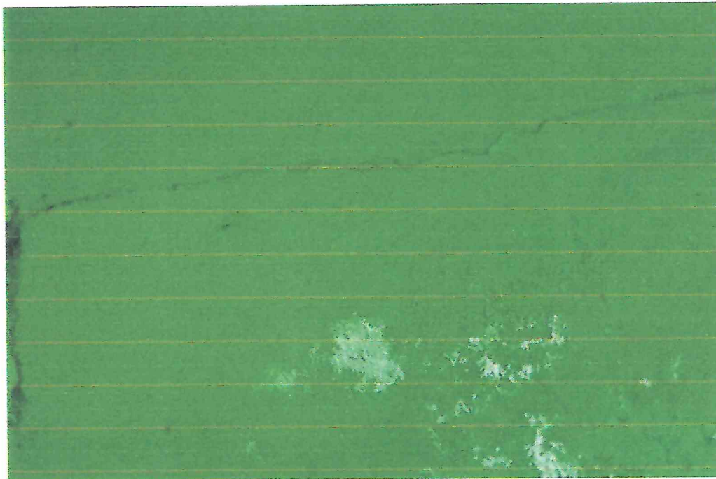
Imagen 10. Grietas en el aplanado causando desprendimientos. Fuente: Visita técnica, septiembre 2021
