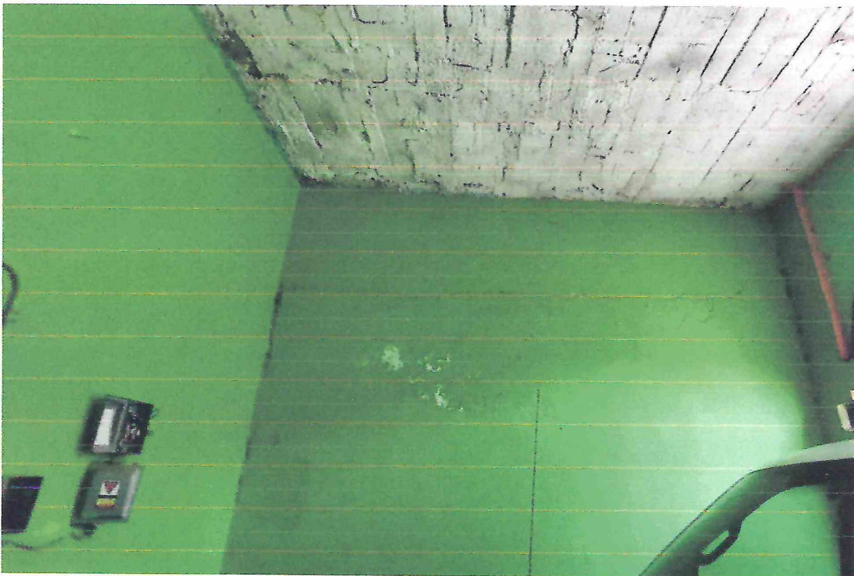
Imagen 09. Desprendimiento de aplanado en muros interiores de la Agencia Municipal de Santiago Nundiche, Oax. Fuente: Visita técnica, septiembre 2021
