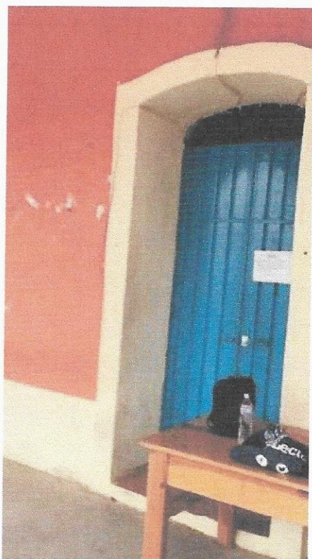
Imagen 11. Puertas de herrería fija y alineadas al paño interior del muro, palacio municipal, Santa Catarina Yosonotú, Tlaxiaco, Oaxaca.
