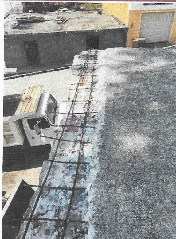
Imagen 12. Losa de concreto armado con 15cm de espesor sobre muros de piedra braza y arcos, palacio municipal, Santa Catarina Yosonotú, Tlaxiaco, Oaxaca.
