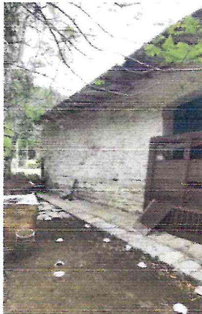
Imagen 10: muros con aplanados con presencia de pinturas y desprendimiento de ellos.
