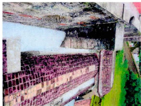
Imagen 5: cubiertas de cúpula y bóveda de cañon, de ladrillo rojo.
