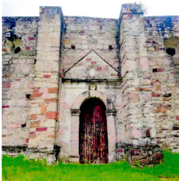
Imagen 9: fachada lateral izquierda, muros y contrafuertes presentan patina y presencia de agentes biológicos, como plantas y musgo por humedad.
