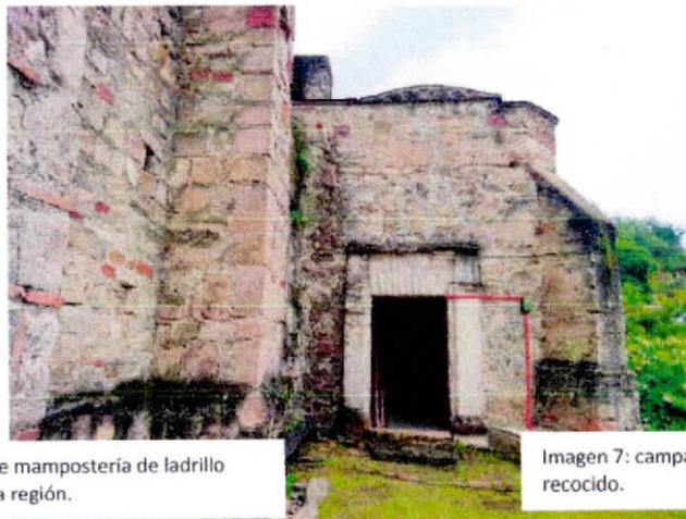
Imagen 6: contrafuertes de mampostería de ladrillo rojo y cantera endémica la región.
