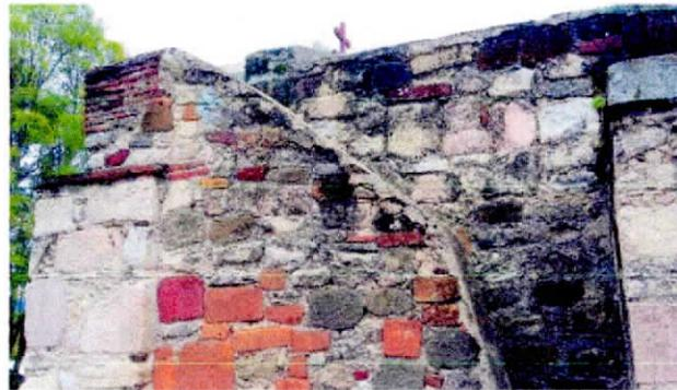
Imagen 4: contrafuertes de mampostería de ladrillo rojo y cantera endémica la región.
