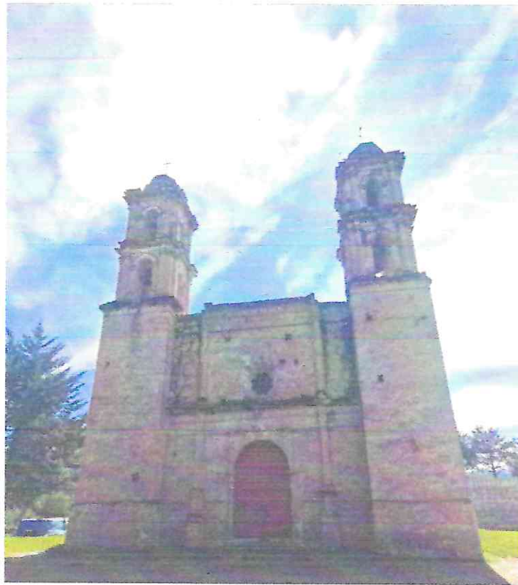
Imagen 01. Fachada Principal de la Iglesia de Santa Catarina Tayata. Fuente: Visita técnica, julio 2021
