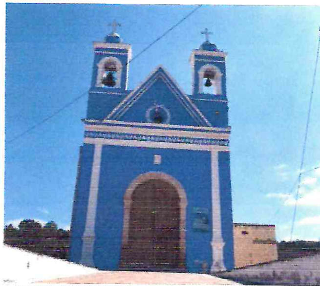
Imagen 2. Fachada principal de la capilla en estado actual
