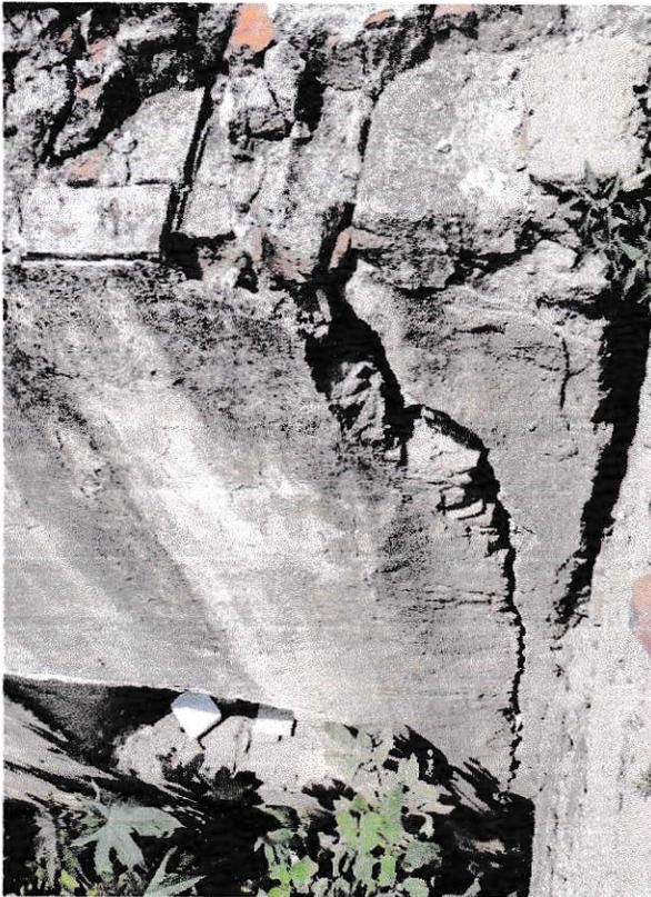
**Imagen 18.** Vista a detalle de la grieta del cuarto, disgregación de material por la misma causa.
