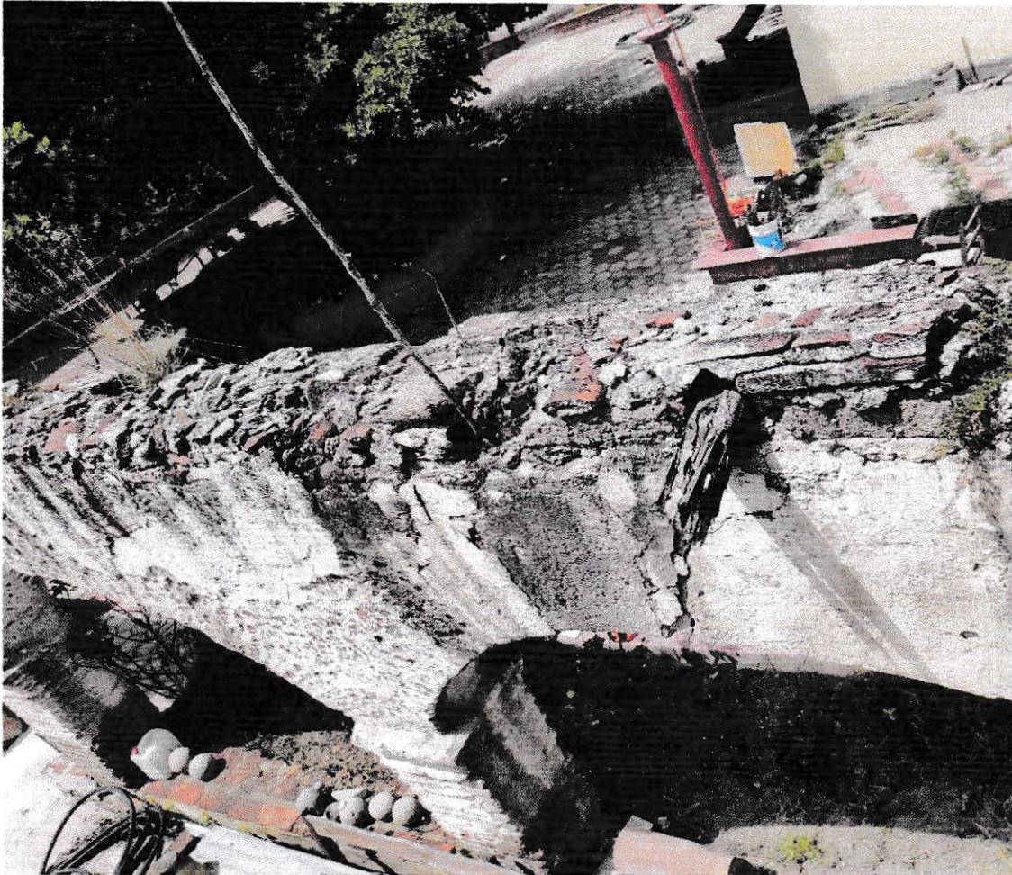
**Imagen 14.** Disgregación de material en la parte superior de los arcos de la fachada principal.
