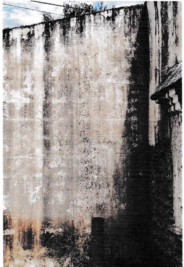
**Imagen 11.** Daños, agrietamientos y desprendimiento de aplanados en muro exterior.
