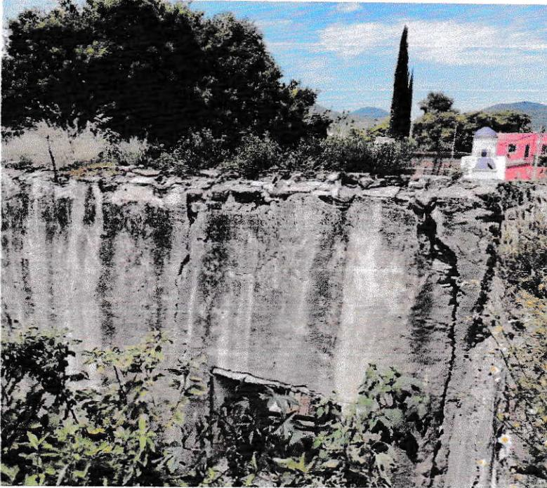
**Imagen 17.** Presencia de agrietamientos con posible afectación en el funcionamiento estructural del muro.
