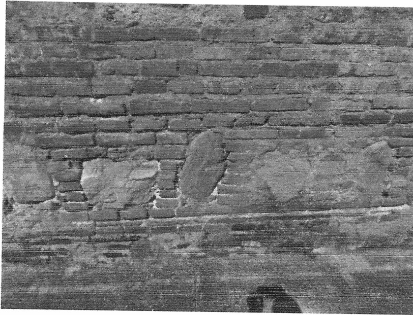
Imagen 13: Muro de nave sobre paramento sur
