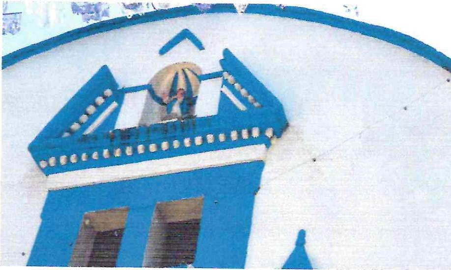
Imagen 17. Se observan grietas y deterioro en el elemento, Fachada Principal. Visita técnica, septiembre 2021
