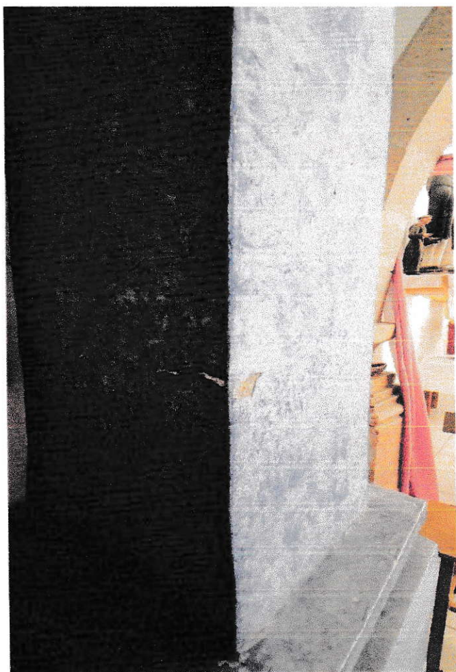
Imagen 13. Contrafuerte templo de Nuestra Señora de Guadalupe de San Juan Bautista Suchitepec. Fuente: Visita Técnica, septiembre 2021.
