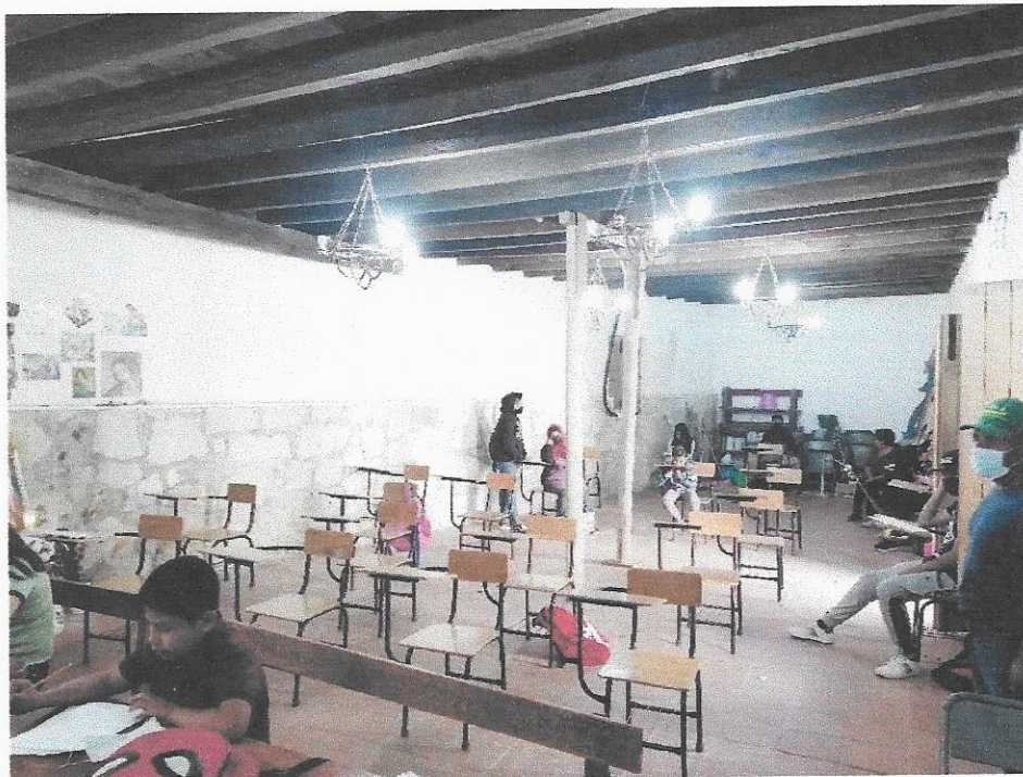
Imagen 05 Vista interior de aulas lado sur. Fuente: Visita Técnica, septiembre 2021.
