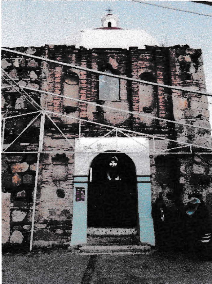
Imagen 05 Vista exterior fachada orientada al Poniente. Fuente: Visita Técnica, septiembre 2021.
