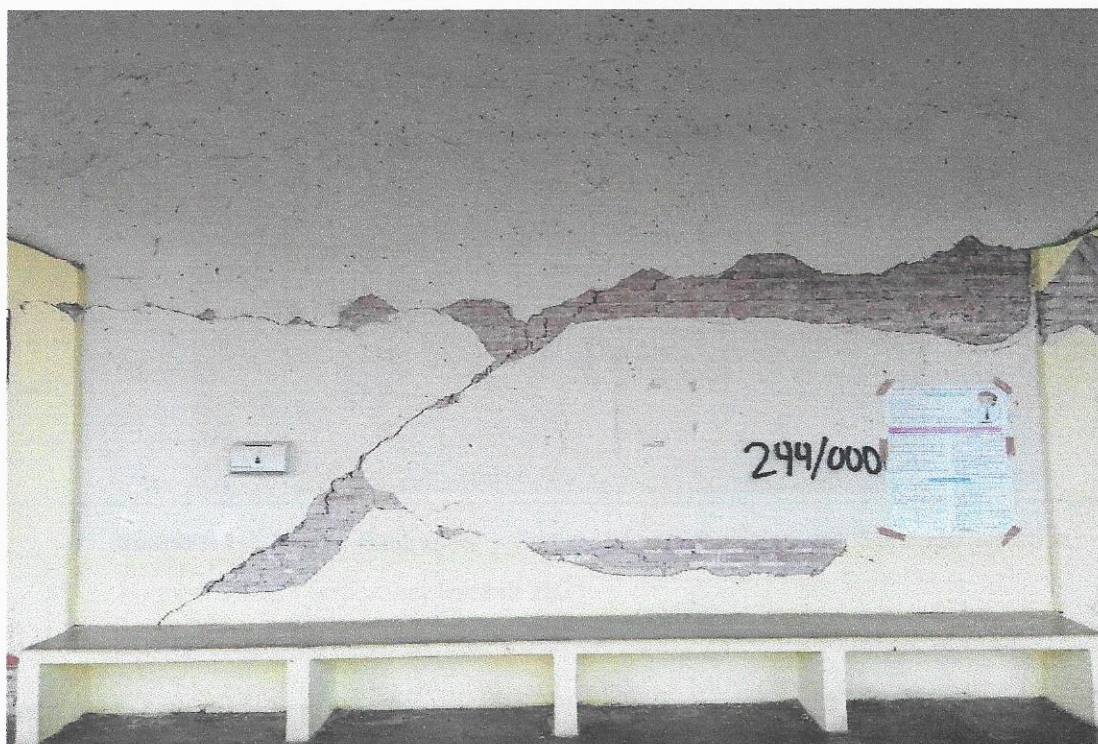
Imagen 13. Muros Palacio municipal de Santiago Niltepec, Juchitán, Oaxaca. Fuente: Visita Técnica, septiembre 2021.
