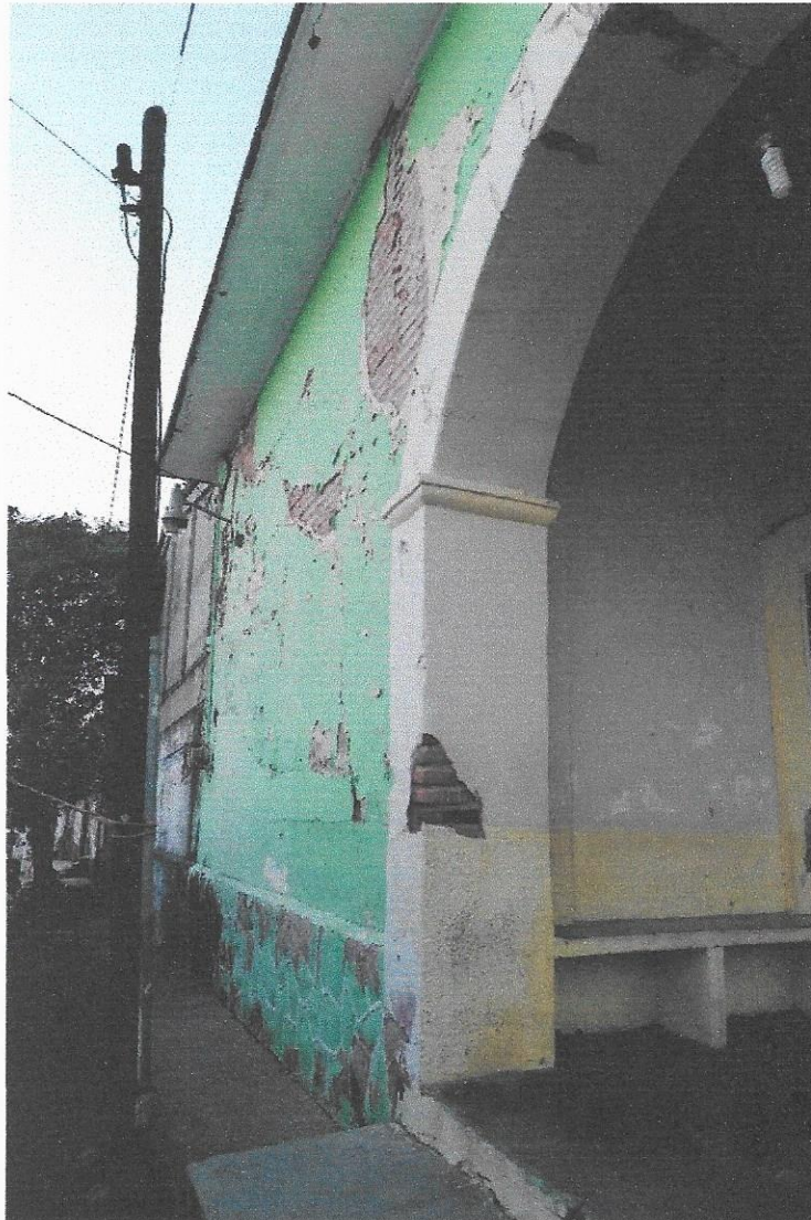
Imagen 14. Muros Exteriores y arcos Palacio municipal de Santiago Niltepec, Juchitán, Oaxaca. Fuente: Visita Técnica, septiembre 2021.
