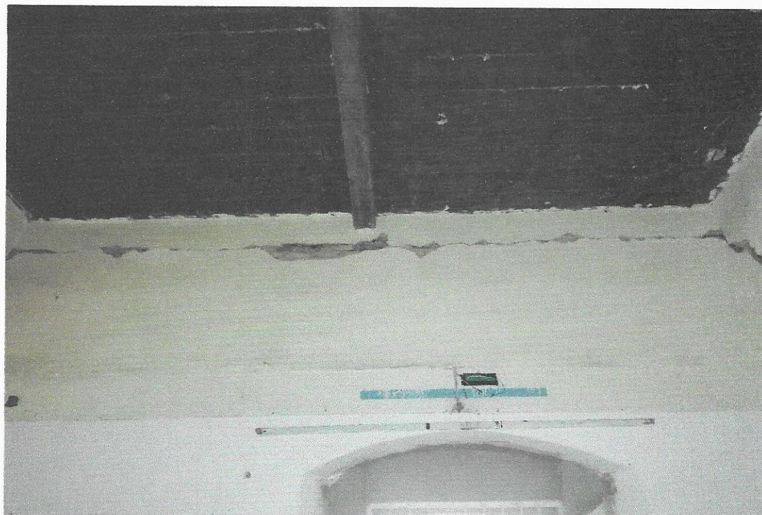
Imagen 15. Cubierta interior Palacio municipal de Santiago Niltepec, Juchitán, Oaxaca.
