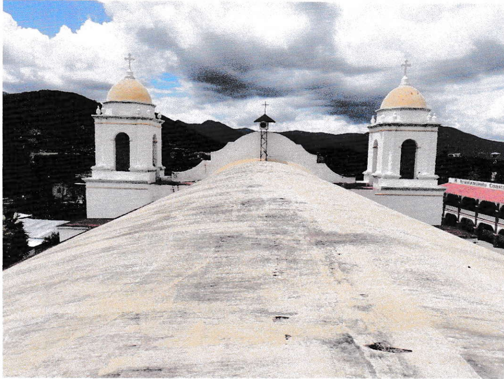
Imagen 08. Vista de la bóveda de cañón del Templo de Santo Tomas Fuente: Visita técnica, septiembre 2021
