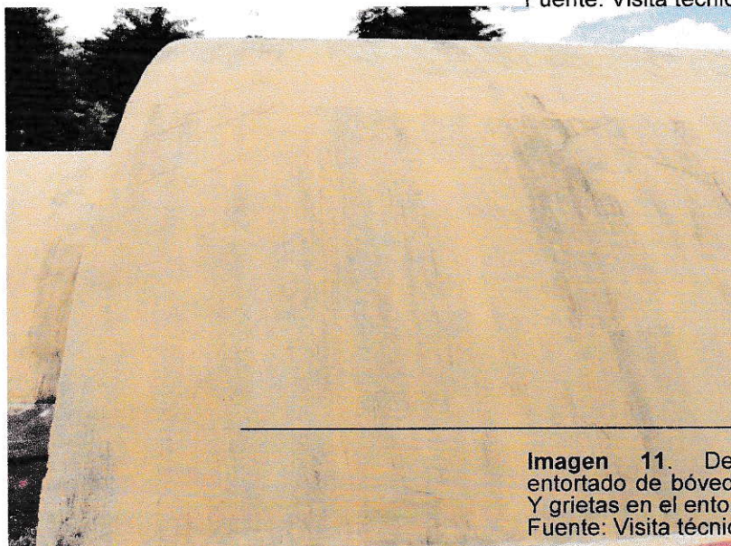
Imagen 10. Desprendimiento del entortado de bóveda de cañón corrido. Fuente: Visita técnica, septiembre 2021
