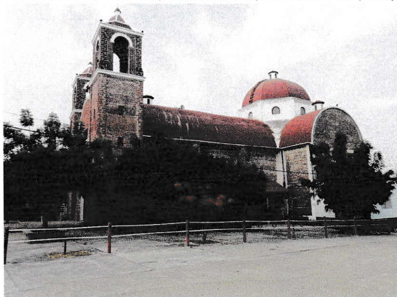
Imagen 10. Vista de las cubiertas del "Templo de San Francisco Cozoaltepec" Fuente: visita técnica
