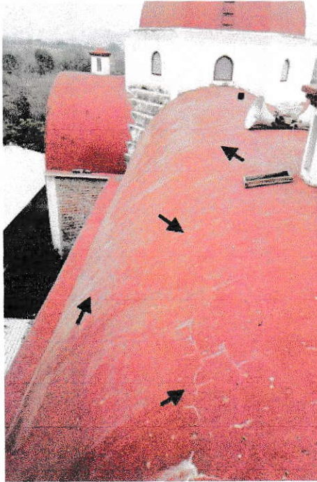
Imagen 19. Grietas provocando filtraciones en la bóveda de cañón corrido de la nave principal del "Templo de San Francisco Cozoaltepec" Fuente: visita técnica
