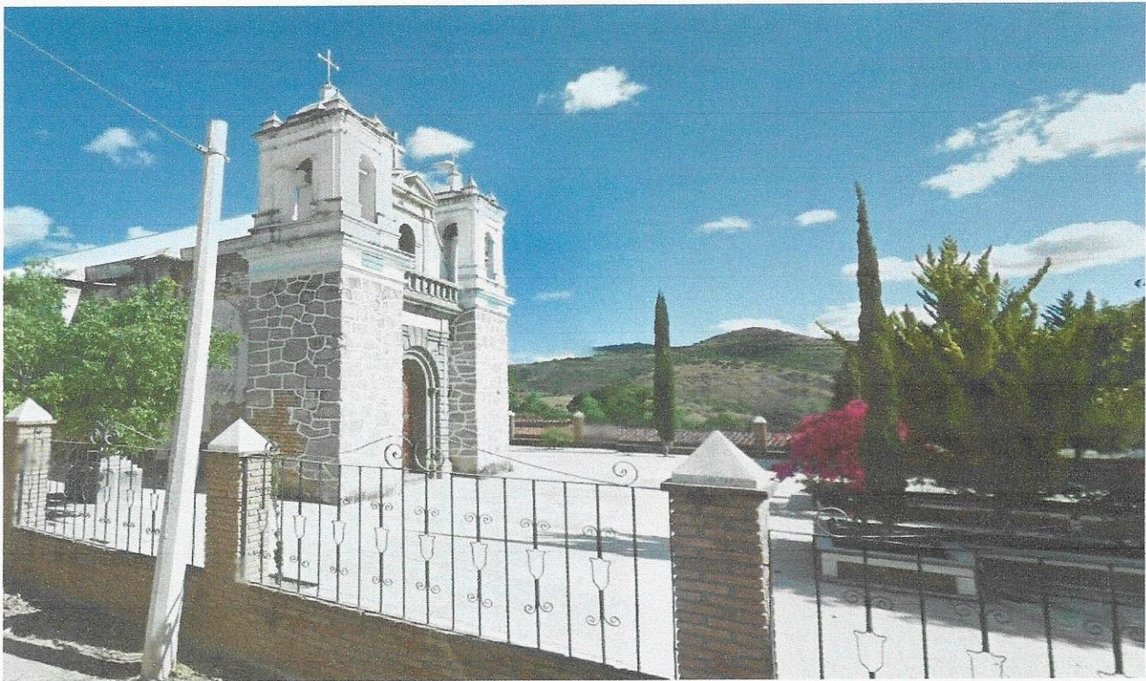
Imagen 04. Fachada, del Templo de San Andrés Niño, Ejutla, Oaxaca. Fuente: Visita Técnica, septiembre 2021.
