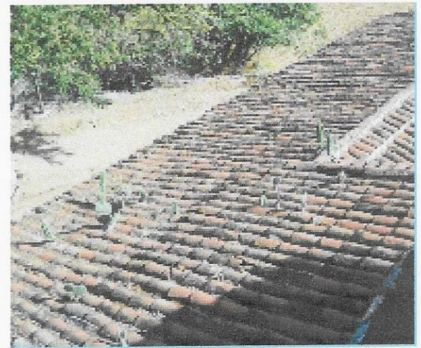
Imagen 22. Cubierta a base de morillos Anexo, Templo de San Andrés Niño. Fuente: Visita Técnica, septiembre 21.
