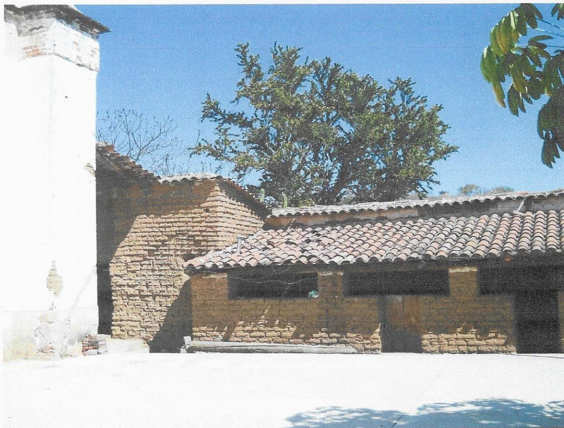
Imagen 05. Fachada, de anexos del templo de San Andrés Niño, Ejutla, Oaxaca. Fuente: Visita Técnica, septiembre 2021.
