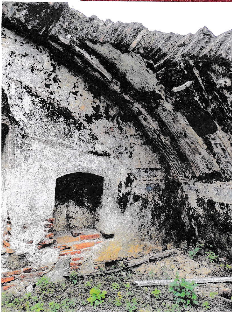
Imagen 15. Colapso parcial de la cúpula del coro, desprendimiento de la capa pictórica del Templo Antigo de Santo Domingo. Fuente: Visita técnica septiembre 2021.
