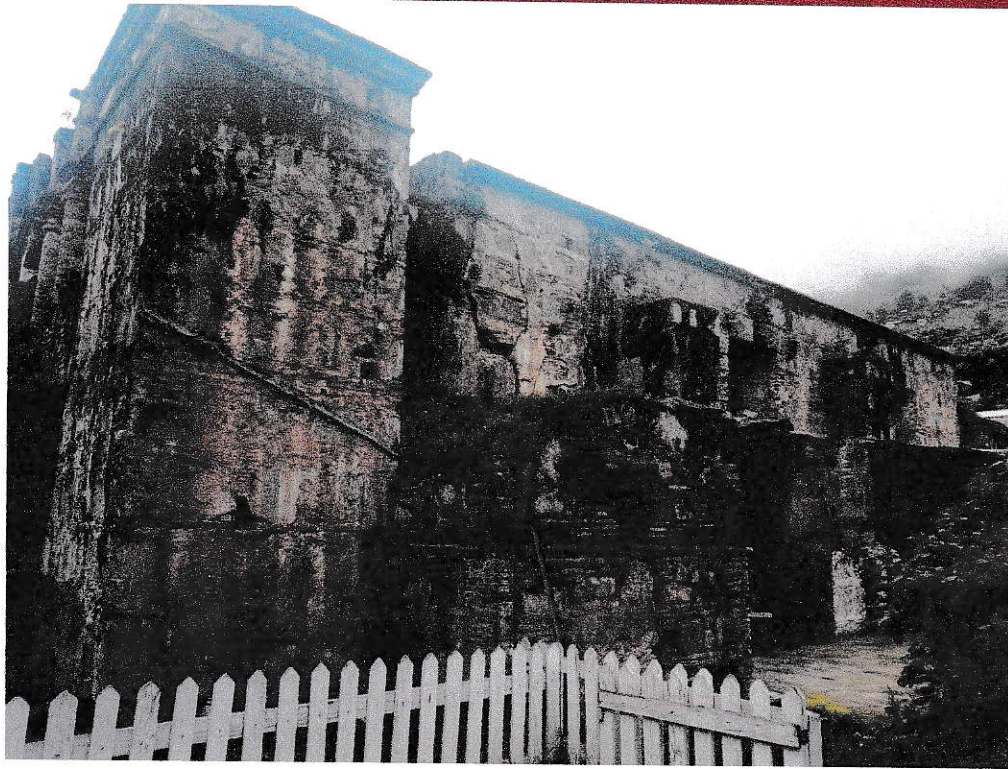
Imagen 16. Fractura de la fachada sur del Templo Antiguo de Santo Domingo, que se proyecta hasta el bautisterio. Fuente: Visita técnica septiembre 2021.
