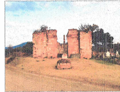
F-02 VISTA FRONTAL PONIENTE, SE OBSERVA DAÑOS OCASIONADOS POR SISMO
