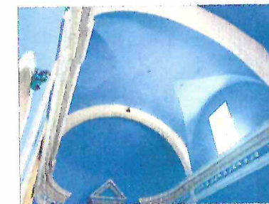
EN LA VISTA INTERIOR DE LAS ALERIAS Y CUBIERTA, SE OBSERVA BARRIL CLASIFICADO POR 1.200.
