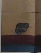
F-05 VISTA HACIA EXTERIOR EN SACRISTIA CON PRESENCIA DE GRETTAS Y DESPRENDIMIENTO DE APLANADO EN MUROS A CAUSA DE SISMO.
