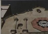
F-02 VISTA HACIA PORTADA FORIADA CON PIEDRA CANTERA DE LA REGION, SE OBSERVA PRESENCIA DE DAÑOS A CAUSA DE SISMO.
