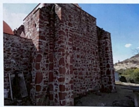
F-06. VISTA GENERAL FACHADA ORIENTE A BASE DE PIEDRA CANTERA ASENTADA CON MORTERO DE CAL-ARENA ASI COMO PEDACERA DE PIEDRA EN JUNTAS.
