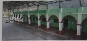
VISTA HACIA FACHADA PRINCIPAL DEL PALACIO, SE DENOTA LAS ARCADAS, COLUMNAS ASI COMO EL CORREDOR. HECHOS DE MATERIALES CONTEMPORANEOS, COMO TABICON Y CONCRETO ARMADO, ASI COMO APLANADOS DE CEMENTO-ARENA.
