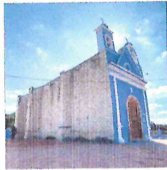
FACCHADA EXTERIOR VISTA DE LA IZQUIERDA
