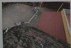
F-03. VISTA GENERAL DE LA CUBIERTA, A BASE DE BORDA DE CANO CORRIDO DE TABIQUE DE BARRIO ROJO ASENTADO Y JUNTADO CON MORTERO DE CAL-ARENA.
