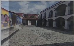
F-02 Visto del patio central a hacia acceso principal.
