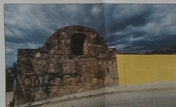
F-02 VISTA GENERAL FACHADA SUR. SE DENOTA LA FABRICA DE PIEDRA DE LA REGION ASI COMO LA CUBIERTA DE TABIQUE DE BARRO ROJO, ASENTADO CON PORTERO CAL-ARENA.
