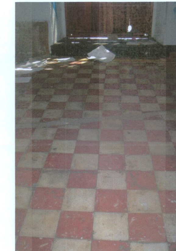
Foto 03.- Piso de cemento pulido cuadrículado de 20 x 20 cms asentado con mortero cemento-arena sobre firme de concreto simple.
