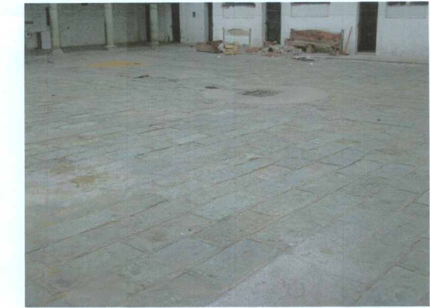
Foto 02.- Baldosa de cantería verde de secciones varias asentada con mortero cemento-arena.
