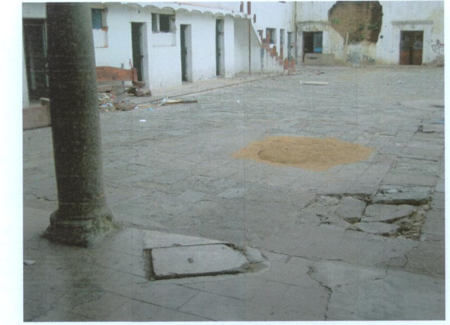
Foto 01.- Piso de cemento pulido rectangular asentado con mortero cemento-arena sobre firme de concreto simple.
