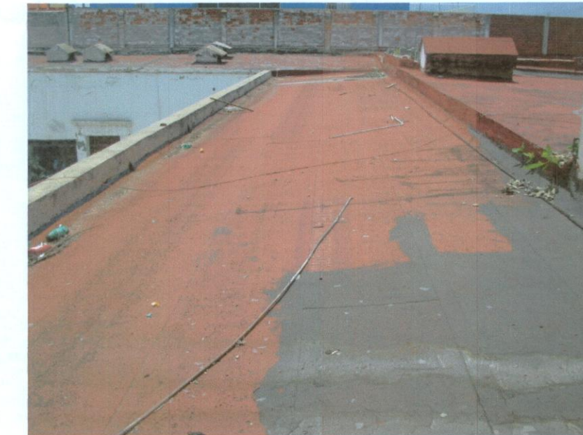
Foto 02.- Terminado con impermeabilizante prefabricado de poliéster color terracota.
