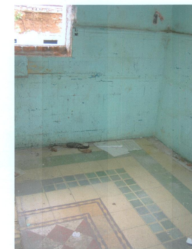
Foto 04.- Piso de cemento pulido cuadrículado de 20 x 20 cms asentado con mortero cemento-arena sobre firme de concreto simple.
