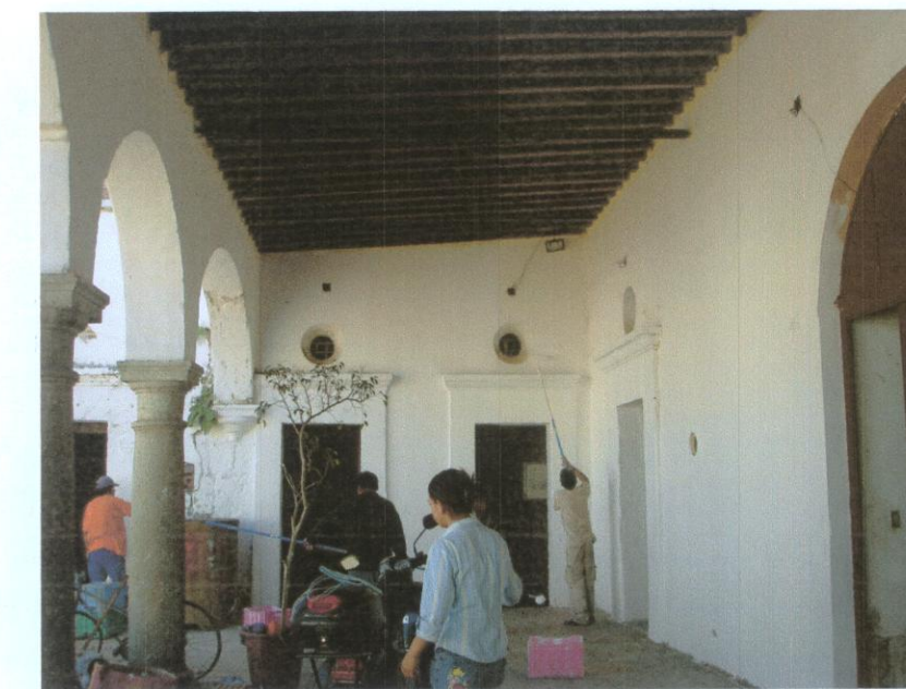
Foto 01.- Cubierta a a base de vigas de madera de pino de 15 x10 cm de sección, tabique rojo sobre vigas, terrado y capa de mortero terminado con impermeabilizante prefabricado de poliéster color terracota .
